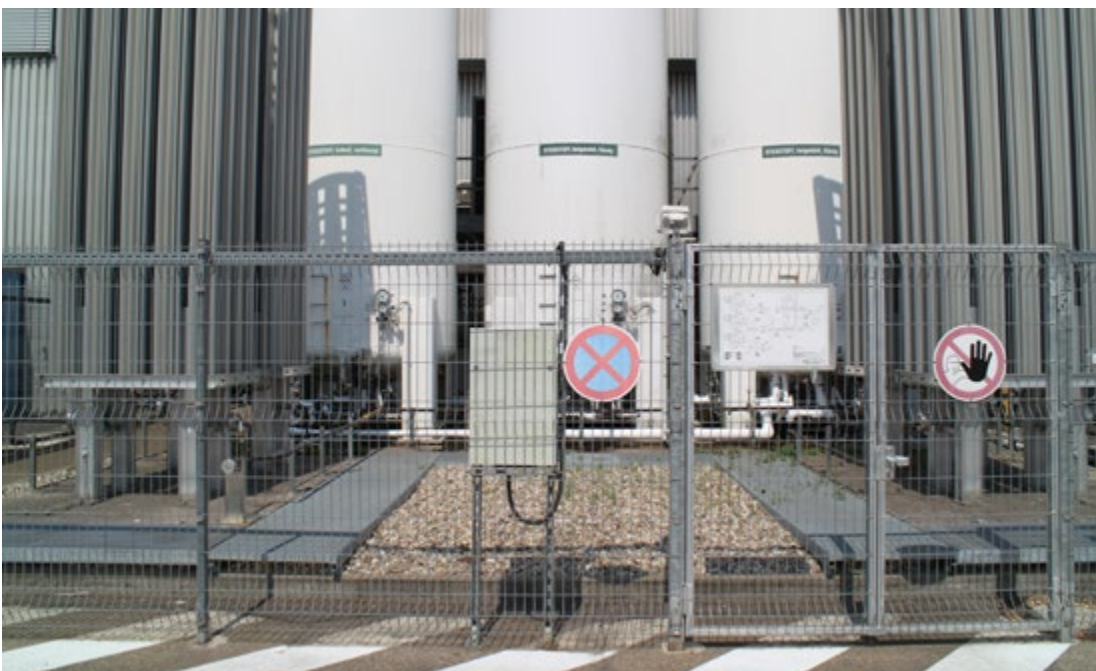
Abb. 30 Stickstofftanks mit Verdampfern
