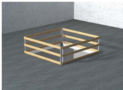
Abb. 79 Sicherung einer Öffnung durch Seitenschutz
