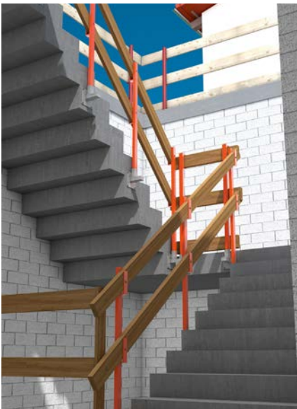
Abb. 78 Treppenaufgang mit Seitenschutz
