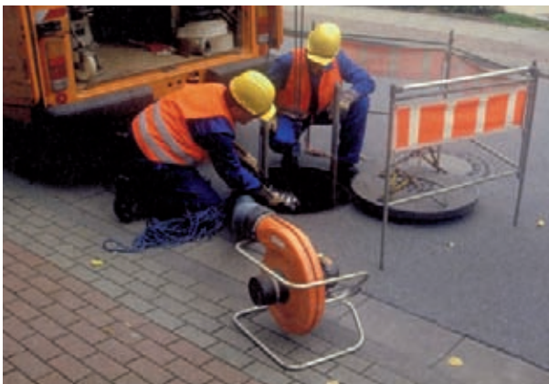
Bild 26: Technische Belüftung (siehe auch Bild 5)
