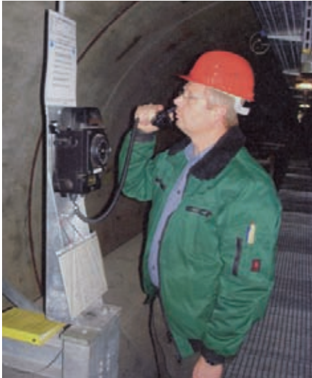
Bild 6: Sicherheitshinweise zur Kanal- begehung
