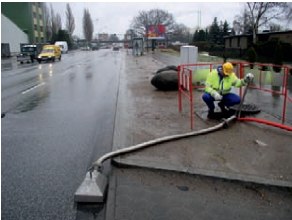
Bild 18: Kontrolliertes Freisetzen von Heizmedium über Metallschlauch
