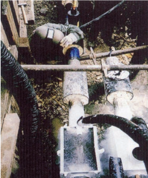
Bild 25: Rohrfrostverfahren
