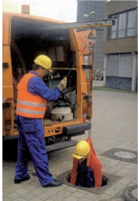
Bild 12: Kragarm mit Hebeeinrichtung
