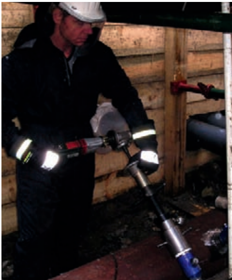
Bild 24: Anbohrverfahren
