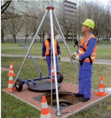
Bild 11: Dreibock mit Hebeeinrichtung
