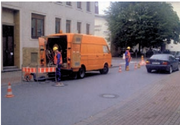
Bild 8: Mit Absperrgitter gesi- cherter Schachtein- stieg
