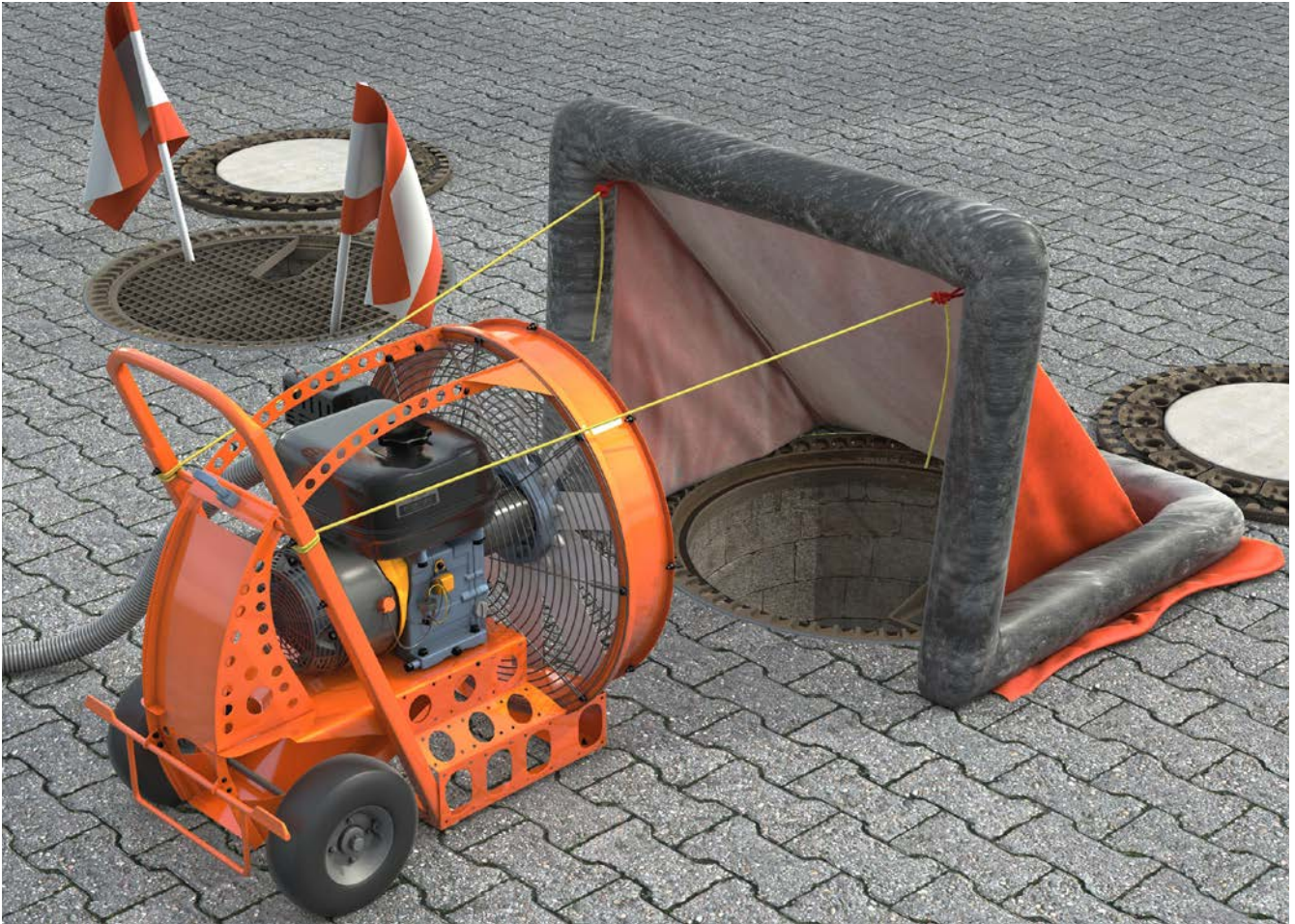
Abb. 31 Mit einer technischen Lüftung wird eine gefährliche Atmosphäre beseitigt.
