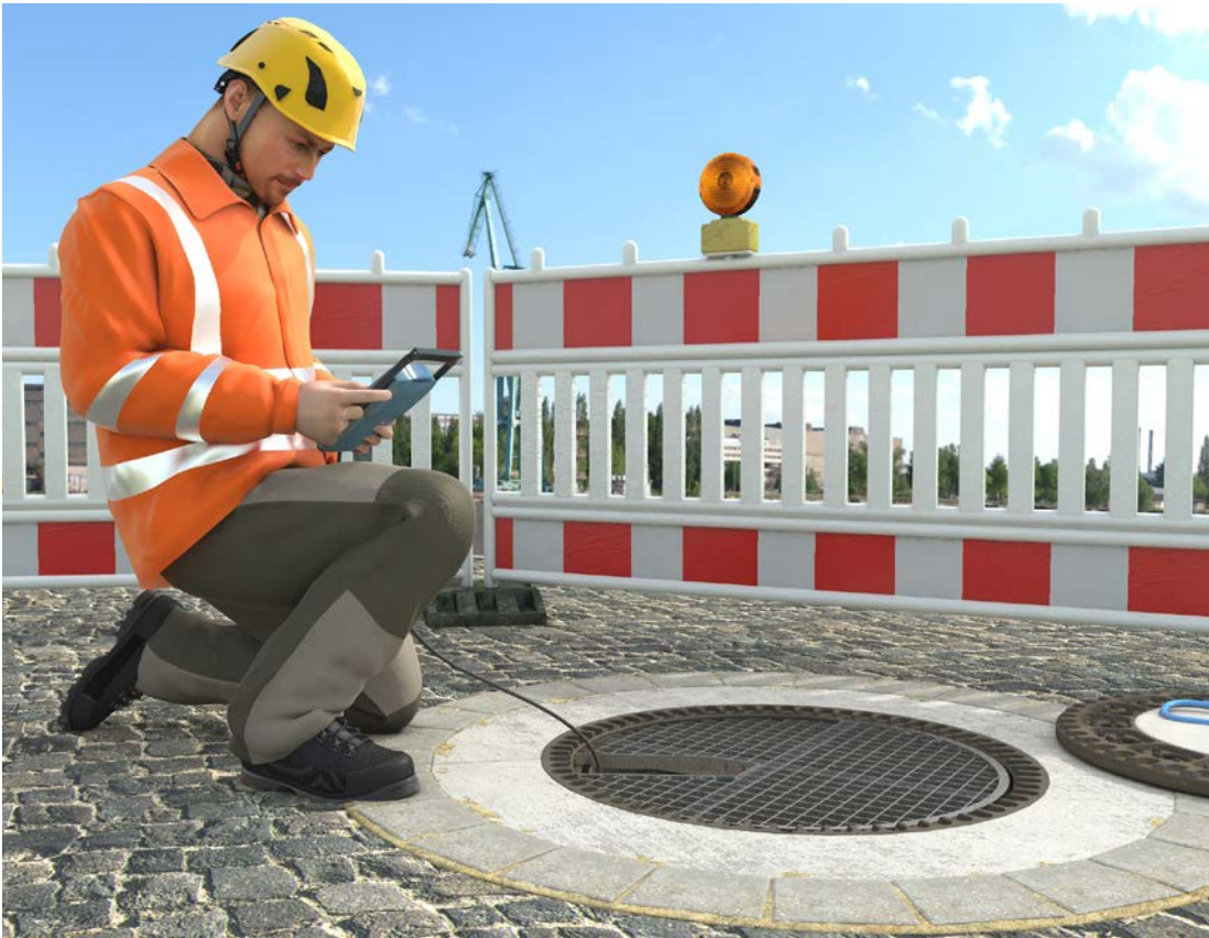
Abb. 29 Eine durch Unterweisung oder Schulung fachkundige Person übernimmt das Freimessen. Mit Hilfe von Ansaugschläuchen kann die Atmosphäre weiter unten geprüft werden.
