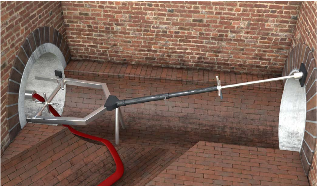
Abb. 32 Die Ausschubsicherung verhindert das Verrutschen der Kanallase.
