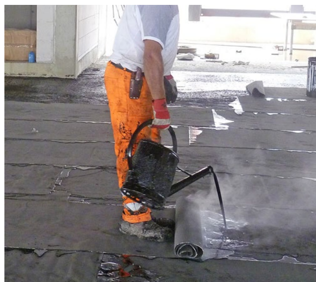
Abb. 28 Einbau von heißem Bitumen
