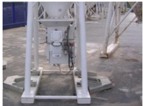
Abb. 4 Verbreiterung der Aufstandsflächen zur Erhöhung der Standsicherheit
