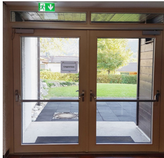
Abb. 18 Notausgang mit Panikstange und Kennzeichnungen
