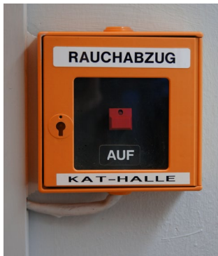
Abb. 40 Auslöseeinrichtung Rauchabzug
