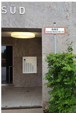
Abb. 32 Beschilderung einer Brandmeldeanlage vor einem Gebäude
