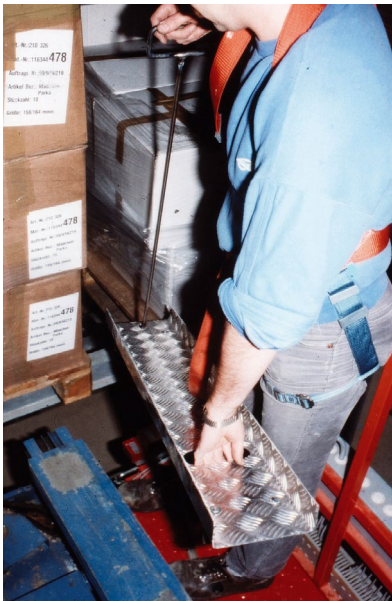
Abb. 14 Einlegen der Schiene in das Regal
