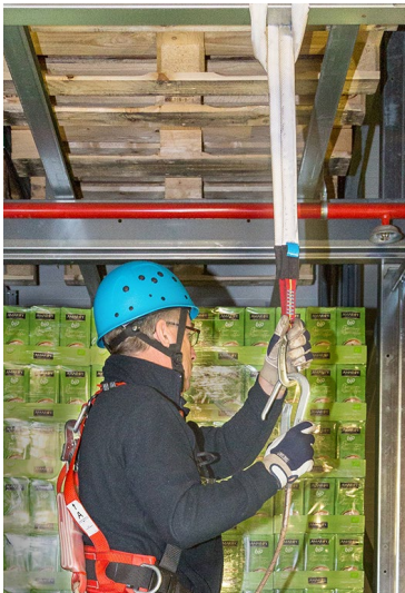
Abb. 4 Sicherung über Kopf an der Regalkonstruktion über Bandschlinge und y-Seil
