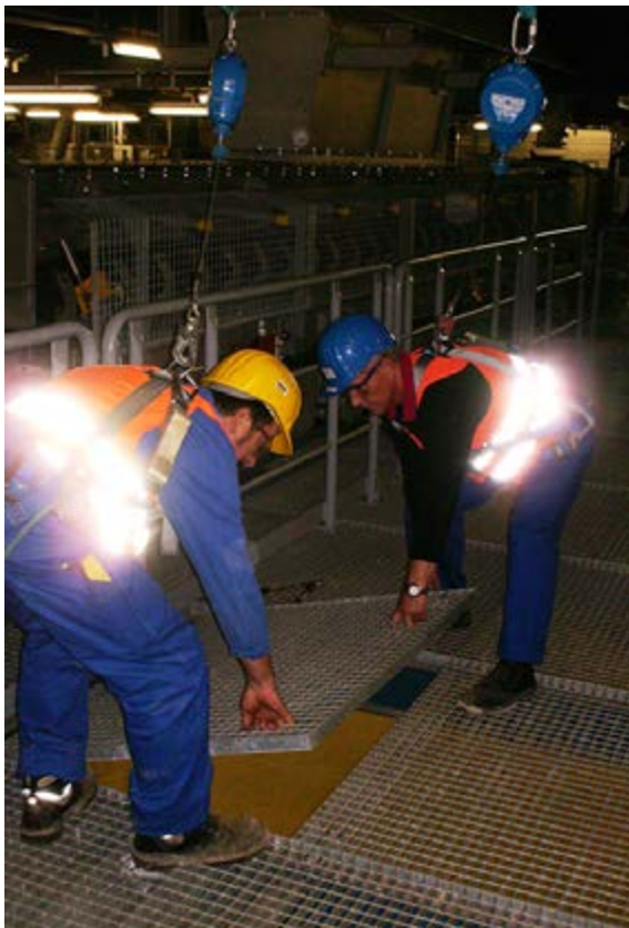
Abb. 5-1 Verlegen von Gitterrosten in ergonomisch ungünstiger Haltung
