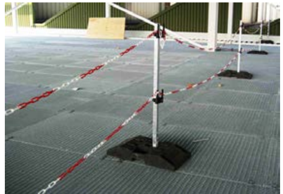
Abb. 4-8 Im sicheren Abstand zur Absturzkante (größer 2,0 m) abgesperrte Gitterrostbühne
