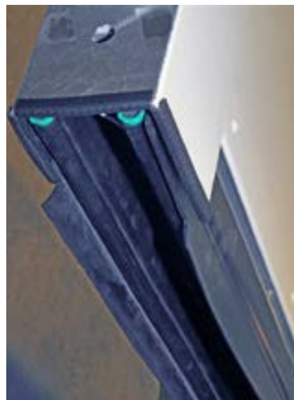
Abb. 8 Hauptschließkante am Tor mit zwei Schaltleisten
