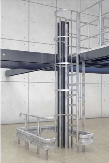
Abb. 19 Steigleiter als Zugang zu einer Maschinenarbeitsbühne
