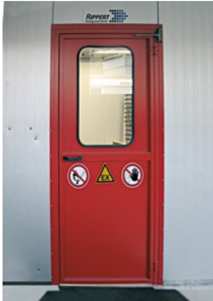
Abb. 18 Kennzeichnung an einem Zugang zum Lackierraum
