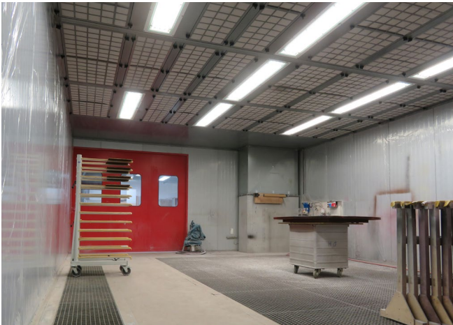
Abb. 48 Lackiererei mit eigenem Trocknungsraum
