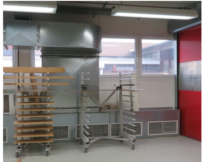
Abb. 45 Absaugung an Hordenwagen
