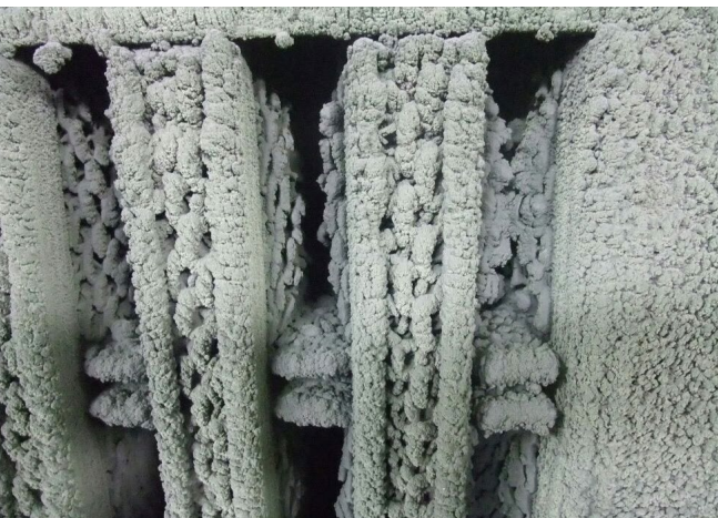
Abb. 44 Voll beladene Kartonfilter mit hoher Brandlast
