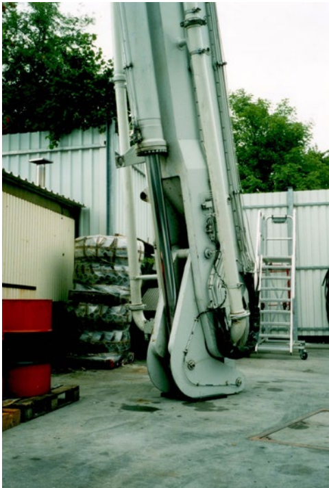
Abb. 38 Auf den Boden abgesenkter Ausleger einer Betonpumpe
