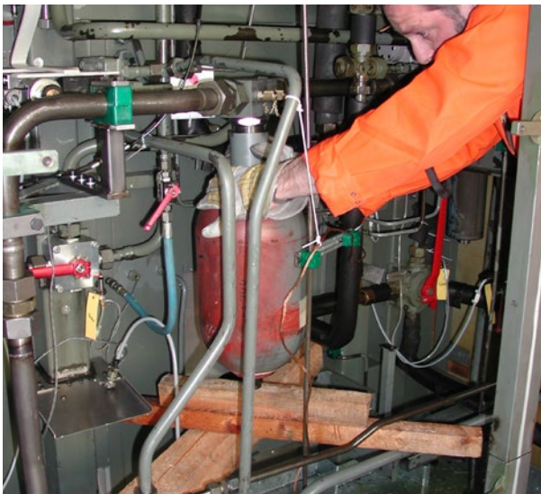
Abb. 1 Instandhalter bei Wartungsarbeiten
