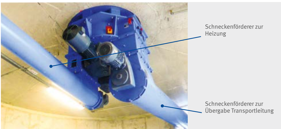
Abb. 6.17 Austragung mit 2 getrennten Übergabestellen
