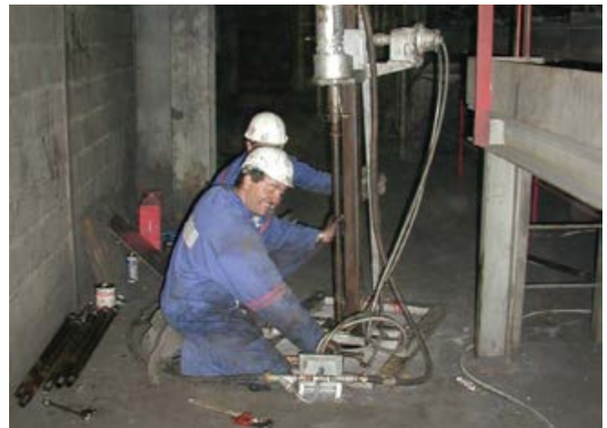
Abb. 8.3 Im Dach zum Speicherraum angesetzte Bohreinrichtung
