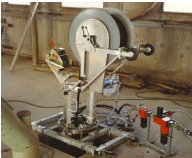
Abb. 8.5 Bedieneinrichtung, Energiezufuhr und Steuerung außerhalb des Späne-Lagerraumes
