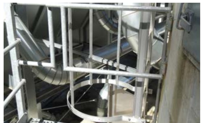
Abb. 5.10 und 5.11 Steigleiter nach ASR 1.8, Nr. 4.6
