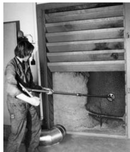
Abb. 7.19 und Abb. 7.20 Abziehen und Absaugen der Späne, Arbeiten außerhalb des Späne-Lager-raumes
