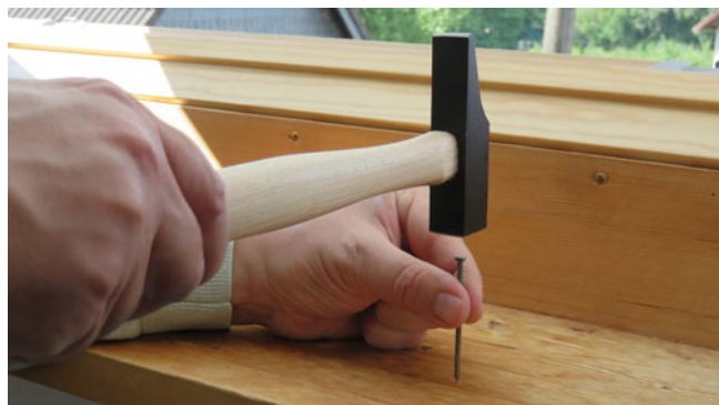
Abb. 17 Nagel oben fassen
