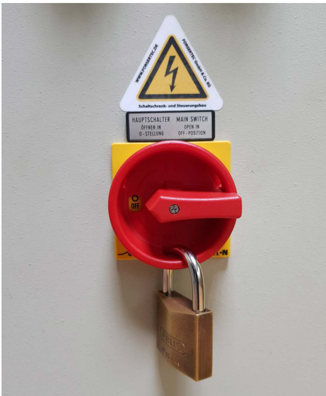
Abb. 7 Hauptschalter (elektrisch)
