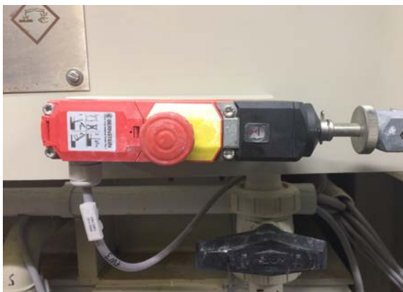
Abb. 2.7 Reißleine, mit Sicherheitseinrichtung gegen Schlaffseil
