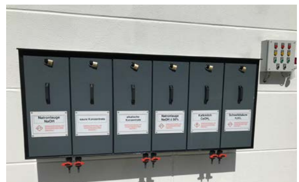
Abb. 8.4 Chemikalienbefüllstation für Tankware
