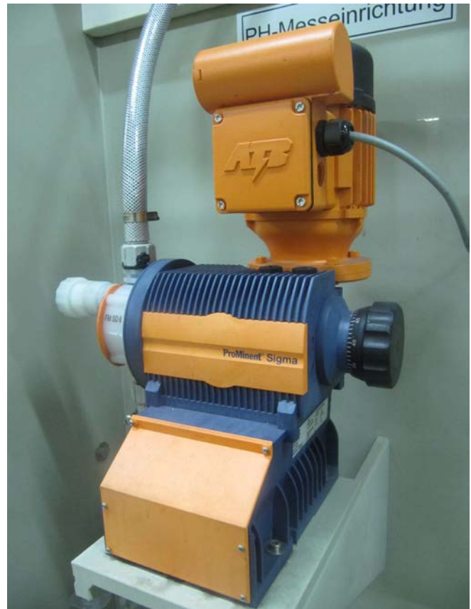
Abb. 10.1 Dosierpumpe als technische Schutzmaßnahme gegen chemische Gefährdungen bei Tätigkeiten der Beschäftigten an den Elektrolyten und Prozessbehältern
