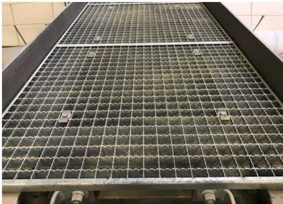
Abb. 2.3 Sicher befestigte Bodenroste
