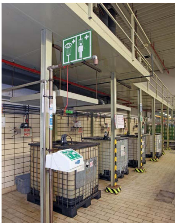
Abb. 1.4: Augendusche und Körpernotdusche im Lagerbereich für Gefahrstoffe
