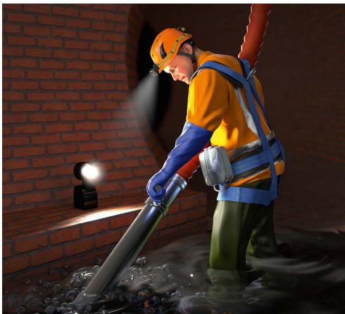
Abb. 6 Beispiel für Schutzkleidung und PSA bei Arbeiten in Abwassertechnischen Anlagen
