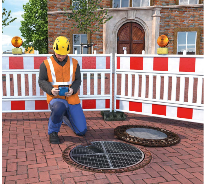
Abb. 14 Überprüfen der Schachtatmosphäre
