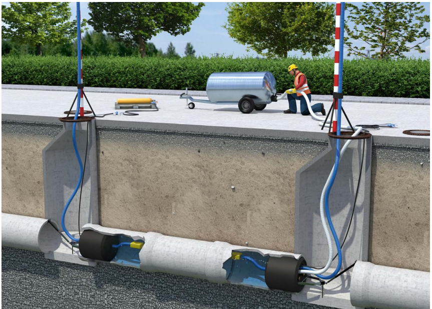
Abb. 16 Durchführung einer Wasserdruckprüfung
