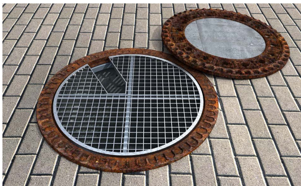
Abb. 13 Durch Abdeckkroste gesicherte Schacht- öffnung
