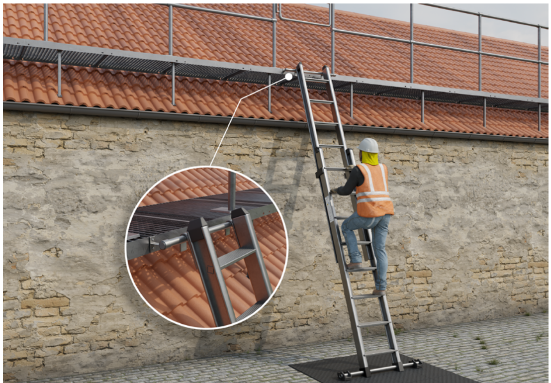
Abb. 19 Leiter mit fester Einhängevorrichtung an einem ertüchtigten Bestandsgebäude mit gesichertem Überstieg
