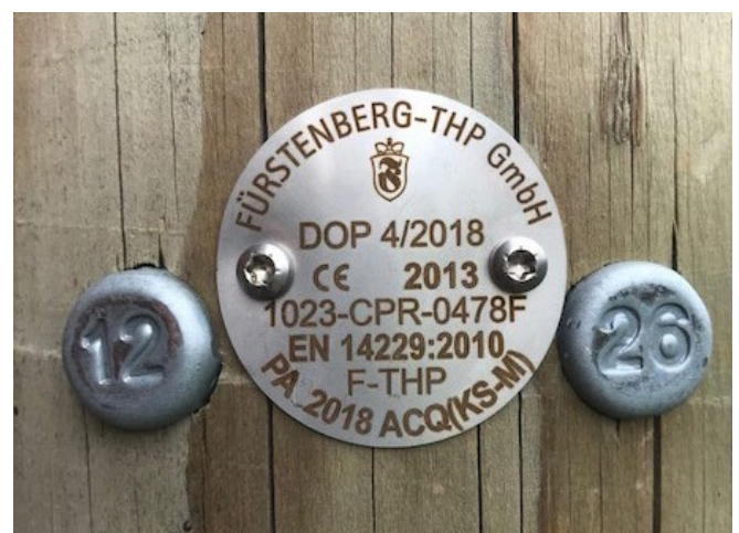
Abb. 2.2.1.1 Beispiel für eine ergänzende Kennzeichnung eines Mastes der Energieversorgung mit Angaben zu Mastlänge (12 m) und Mastfußdurchmesser (26 cm)
