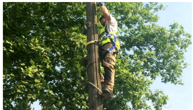
Abb. 7.4.5.1.d Abklopfen des zu besteigenden Bereiches
