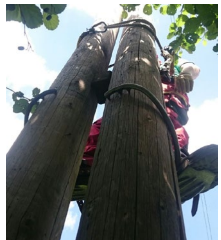
Abb. 7.8.2.f Das Besteigen von Doppelmasten kann ggf. auch die Verwendung der Steigeisen an beiden Masten erfordern.
