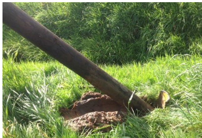
Abb. 5.2.2.2 Mastabgleiter zum Stellen von Holzmasten in Mastlöchern
