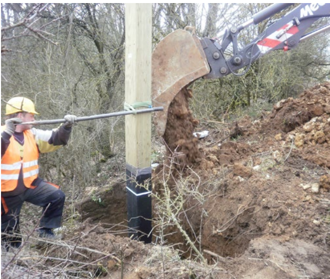
Abb. 5.1.1 Die Markierung am Holzmast erleichtert die Einhaltung der erforderlichen Eingrabetiefe z. B. bei Hanglagen.
