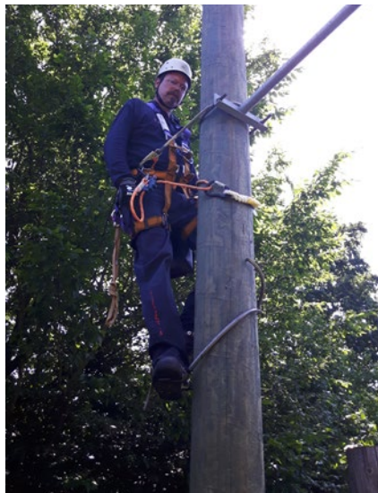
Abb. 7.8.2.b Anlegen des zweiten Halteseils oberhalb des Querriegels
