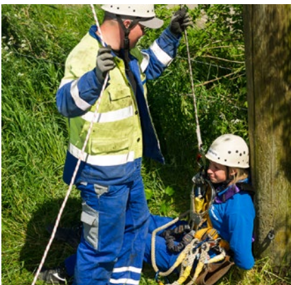
Abb. 10.a Beispiel für ein geeignetes Rettungssystem zur Rettung von Personen an Holzmasten, das am Arbeitsplatz bereitzuhalten ist.
