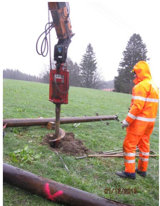
Abb. 5.1.2 Beispiel für den Einsatz eines hydraulisch betriebenen Erdbohrers
