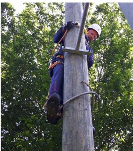
Abb. 7.8.2.d Entfernen des zweiten Halteseils
