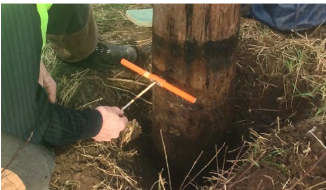
Abb. 7.4.5.1.c Falls erforderlich, ist zur Beurteilung des Materialzustandes mittels Zuwachsbohrer eine Bohrkernprobe zu ziehen.
