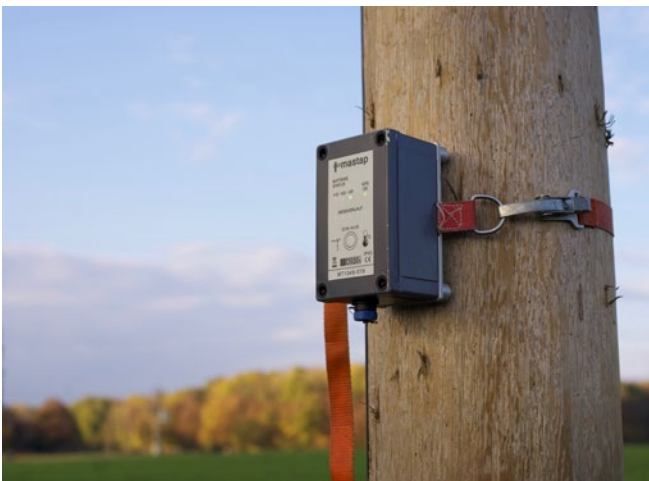
Abb. 7.4.5.3.a Befestigung des Messaufnehmers am Holzmast
