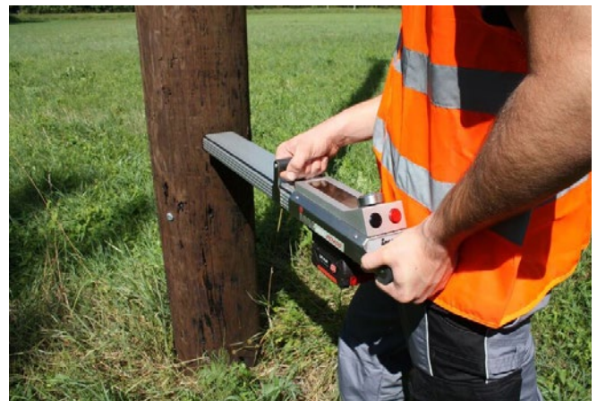
Abb. 7.4.5.2.b Im Einzelfall können zur Beurteilung des Materialzustandes weitere Bohrwiderstandsmessungen an zusätzlichen Mastabschnitten erforderlich sein.
