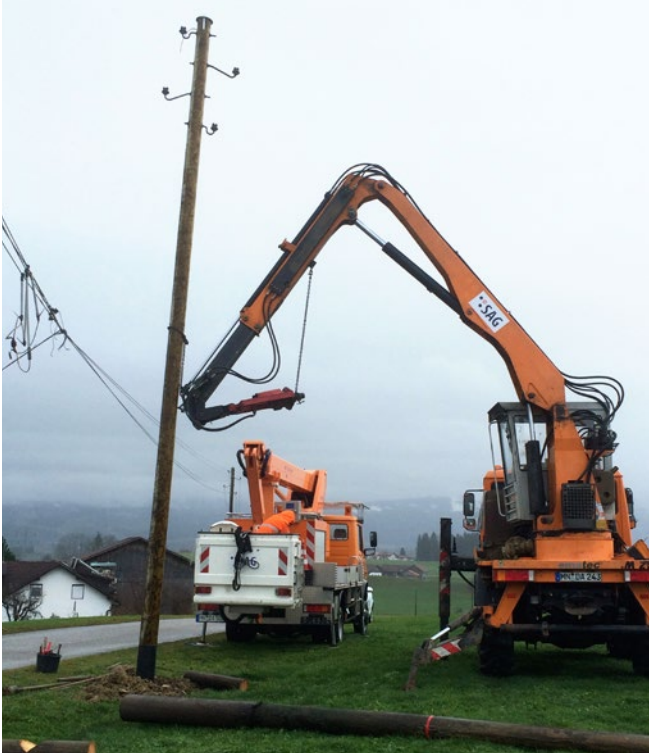
Abb. 7.6.4 Beispiel für eine Sicherung gegen Umstürzen mittels Kraneinsatz
