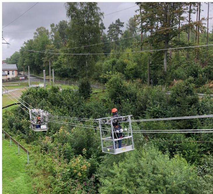
Abb. 135 Beispiel für den Zugang zu einer zu rettenden Person in einem Leitungsfahrzeug mittels eines Rettungsfahrwagens ohne Kraftantrieb, der für den Rückweg über eine Seilwinde zum Freileitungsmast gezogen wird.
