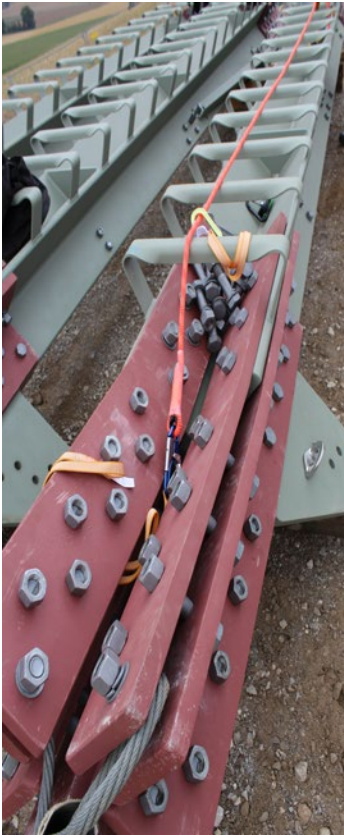
Abb. 161 Beispiel für die Ausrüstung eines Eckstiels vor dem Stockprozess mit einer beweglichen Führung zur anschließenden Verwendung mit einem mitlaufenden Auffanggerät.
