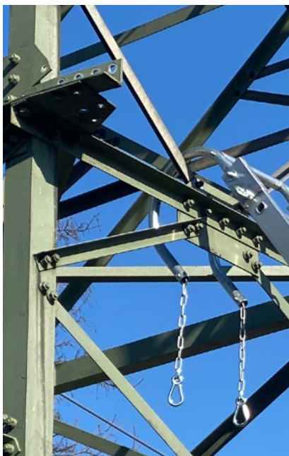
Abb. 83 Unmittelbar nach Erstbestieg werden am Einhängebügel beidseitig die Sicherungen montiert.
