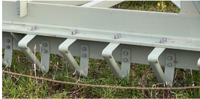
Abb. 162 Große Eckstiele mit Schmetterlingsprofilen sind i. d. R. mit Steigbügeln ausgestattet. Ist eine Freigabe verschweißter Steigbügel zur Verwendung als Anschlagpunkte für PSAGa nicht möglich, können bei geeigneter konstruktiver Auslegung verschraubte Steigbügel als Anschlagpunkte für PSAGa zum Einsatz kommen.
