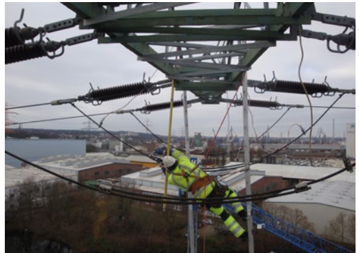
Abb. 114 Einsatz einer Hängeleiter unter Verwendung eines mitlaufenden Auffanggeräts einschließlich beweglicher Führung. Die optimale Schutzwirkung dieses Auffangsystems setzt das kontinuierliche Nachführen des mitlaufenden Auffanggeräts voraus. Anderenfalls bestehen durch Schlaffseilbildung Gefährdungen durch unzulässige Absturzhöhen, die zu einer erhöhten Krafteinwirkung auf das Auffangsystem und dessen Benutzer führen.
