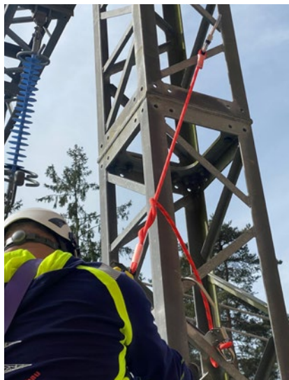
Abb. 62 Beispiel für den Einsatz eines Y-Seils gemäß Abb. 41 beim Besteigen eines Notgestänges. Beim wechselseitigen Anschlagen kann es zu einem Verdrehen der Verbindungsmittel kommen.
