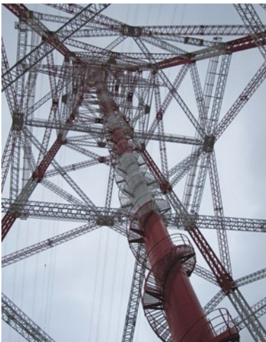
Abb. 2 Freileitungsmast mit Aufzugsschacht, Bühnen und Treppen an der Elbekreuzung.
