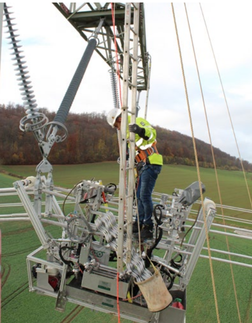
Abb. 123 Zustieg zu einem einzuhängenden Leitungsfahrzeug über eine Hängeleiter im Bereich einer Hängekette.
