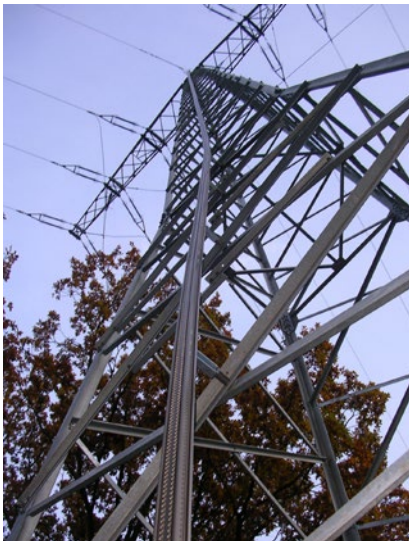
Abb. 14 Beispiel für eine Steigschiene die mit zugehörigen Steigschuhen benutzt wird. Die Schiene dient gleichzeitig als Steigschutzeinrichtung und kann alternativ auch mit einer elektromotorisch betriebenen Befahreinrichtung benutzt werden.
