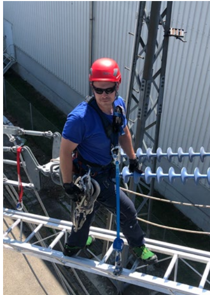
Abb. 106 Ein speziell konfektioniertes Höhengsicherungsgerät verbindet die Anschlageneinrichtung mit dem Auffanggurt.
