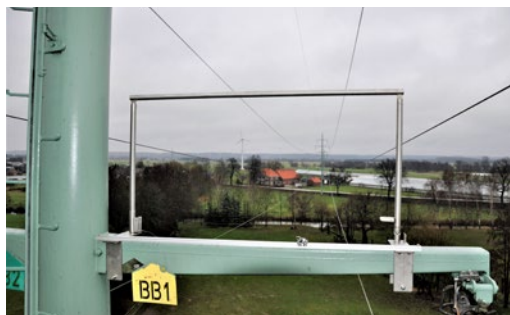
Abb. 98 Stahlvollwandmast mit fester Führung und begehbare Traverse mit klappbarem Hand- lauf und horizontaler Anschlageinrichtung.
