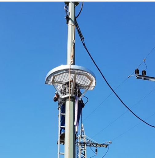
Abb. 88 Beispiel für eine Maststeigleiter ohne feste Führung.
