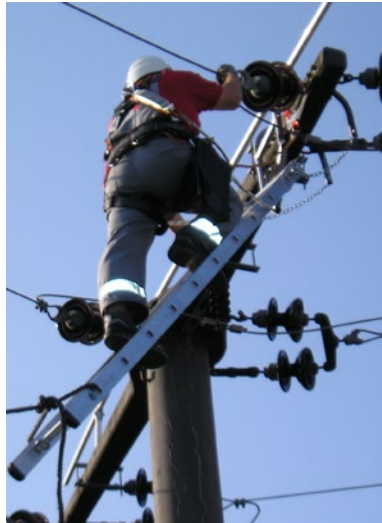
Abb. 116 Einsatz einer Abspannleiter mit verstellbarem Aufhängekopf.
