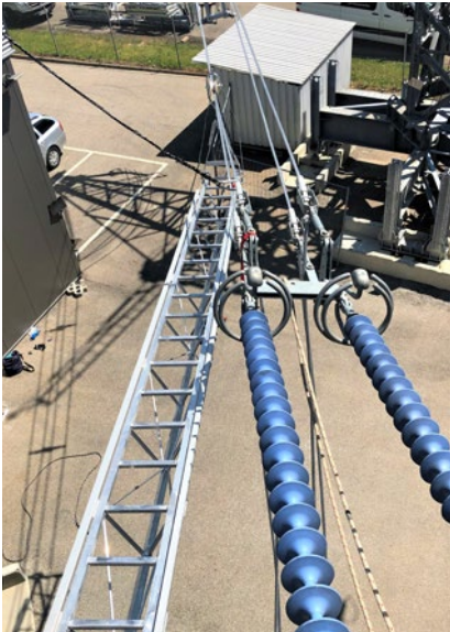
Abb. 105 Montagebühne mit integrierter Anschlageneinrichtung – hier als Schienensystem nach DIN EN 795 Typ D.
