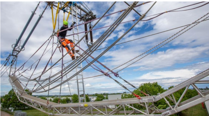
Abb. 117 Beispiel für den gesicherten Aufstieg von einer Traverse auf eine Schlaufenbühne unter Verwendung einer Hängeleiter.
