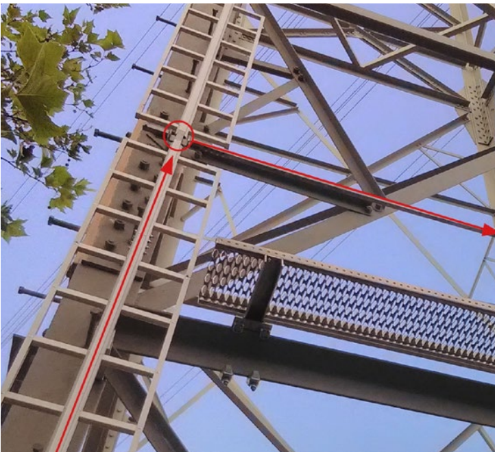
Abb. 13 Die Ausstattung der festen Führung der Steigleiter mit einer „Weiche“ ermöglicht einen ununterbrochenen Schutz gegen Absturz. Das mitlaufende Auffanggerät wird über die „Weiche“ auf die horizontale Anschlagvorrichtung der Mastbühne geführt.
