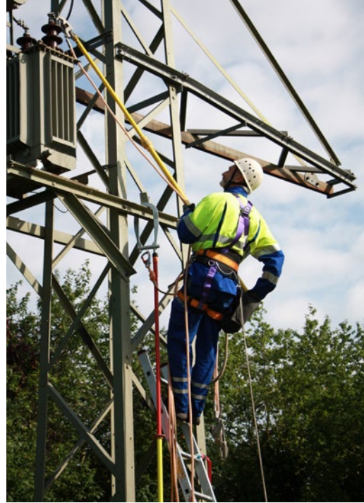
Abb. 94 Beispiel für den Einsatz einer Sprossenanlegeleiter bei der Feststellung der Spannungsfreiheit und dem Erden und Kurzschließen unter Verwendung geeigneter PSAGa und zusätzlich unter Verwendung eines Halteseils zur Arbeitsplatzpositionierung.
