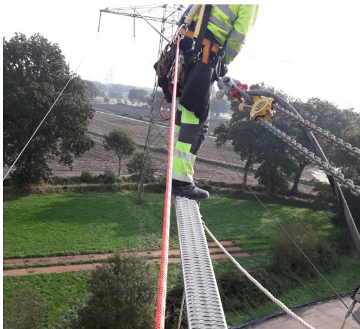
Abb. 112 Das als horizontale Anschlag-einrichtung fungierende Sicherungsseil ermöglicht eine bedienungsfreie Bewegung des mitlaufenden Auffanggeräts.
