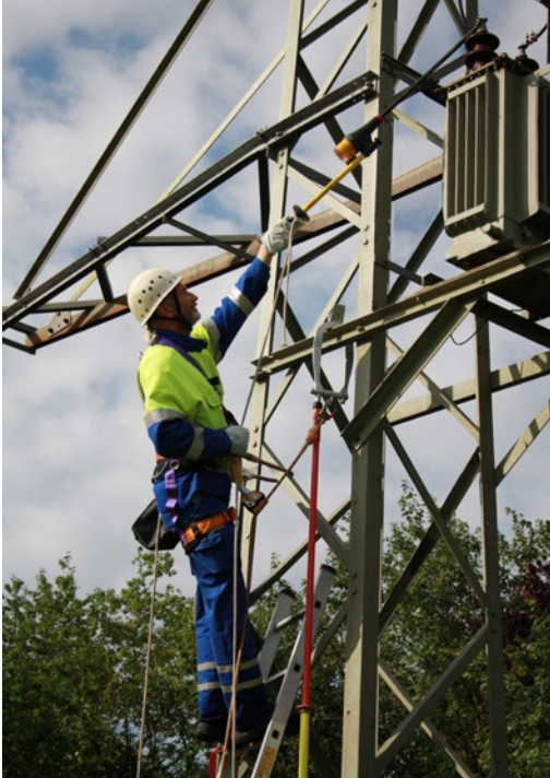
Abb. 94 Beispiel für den Einsatz einer Sprossenanlegeleiter bei der Feststellung der Spannungsfreiheit und dem Erden und Kurzschließen unter Verwendung geeigneter PSAGa und zusätzlich unter Verwendung eines Halteseils zur Arbeitsplatzpositionierung.
