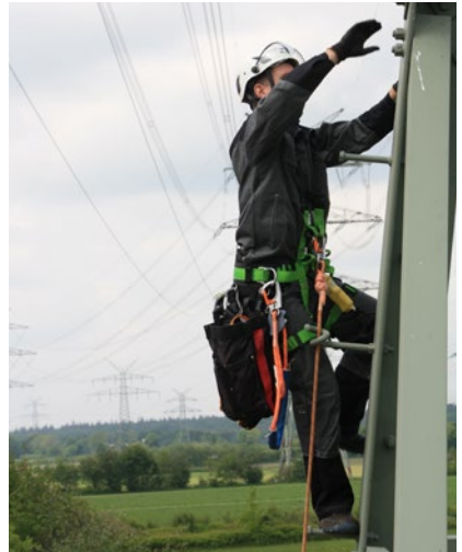
Abb. 72 Beispiel für einen Steigbolzen-gang. Um die Absturzhöhe möglichst gering zu halten, ist hier jeder vierte Steigbolzen mit einer Sicherheitseinrichtung ausgeführt.
