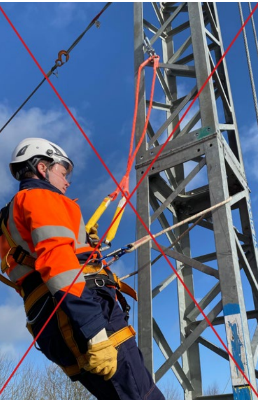
Abb. 60 Beispiel für eine falsche Verwendung zweier einzelner Verbindungsmittel mit Falldämpfer.
