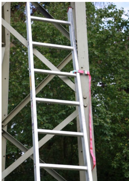
Abb. 78 Durch schräges Anstellen der Anlegeleiter liegen beide Holme bündig an der Diagonalen an. Eine Kopfpunkt-sicherung erhöht die Standsicherheit.
