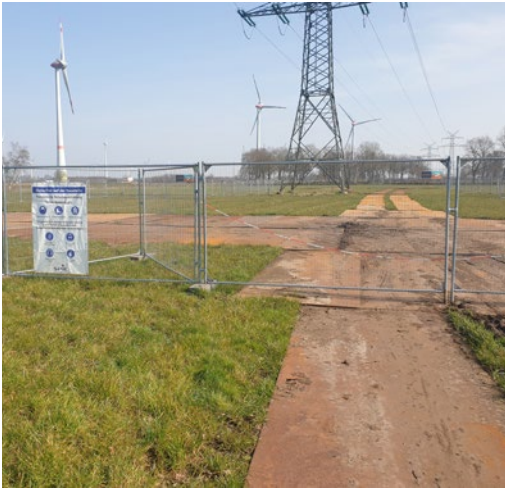
Abb. 148 Beispiel für eine Baustellenabspernung durch einen Bauzaun.
