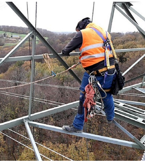
Abb. 100 Begehen einer Traverse unter Anwendung der Schlaufenmethode.
