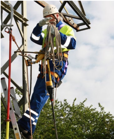
Abb. 93 Beispiel für den Einsatz einer Sprossenanlegeleiter an einem Gittermast. Der Schutz gegen Absturz erfolgt durch geeignete PSaGA, wie z. B. durch mitlaufende Auffanggeräte einschließlich beweglicher Führung. Um ein sicheres Arbeiten und einen sicheren Materialtransport, hier Hochziehen eines Spannungsprüfers, zu gewährleisten ist der zusätzliche Einsatz eines Halteseils unverzichtbar.
