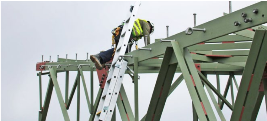
Abb. 158 Beispiel für ein mit PSaGA gesichertes Übersteigen von einer Anlegeleiter auf den Deckel eines vorzumontierenden Mastschusses. Die Leiter ist durch die Steigbolzen gegen Wegrutschen und Kippen gesichert und überragt den Anlegepunkt um \geq 1 m.
