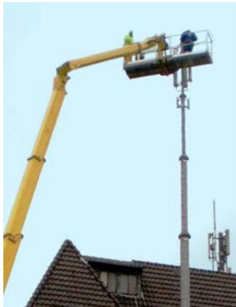
Abb. 10 Einsatz einer Hubarbeitsbühne zur Wartung einer Funkanlage
