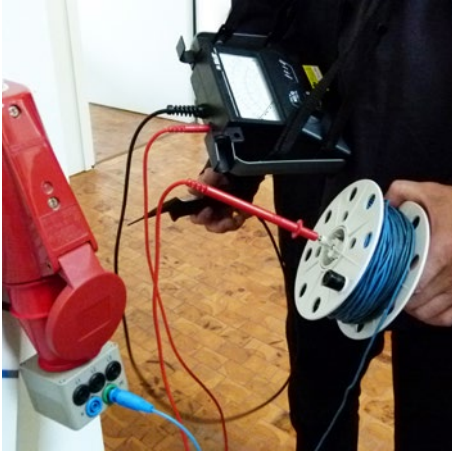
Abb. 8 Messung der niederohmigen Schutzleiterverbindung
