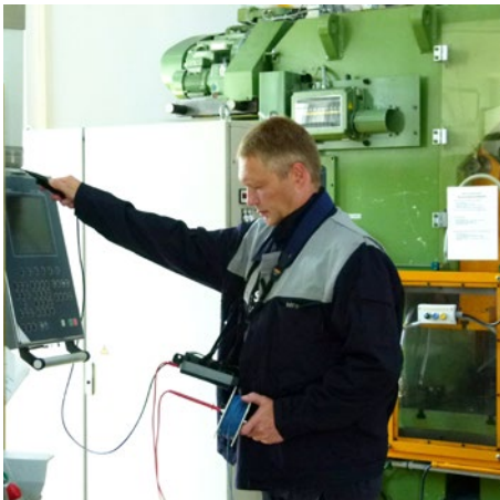
Abb. 10 Schutzleiterwiderstandsmessung; Messung der niederohmigen Schutzleiterverbindung; Bedienpult einer Maschine
