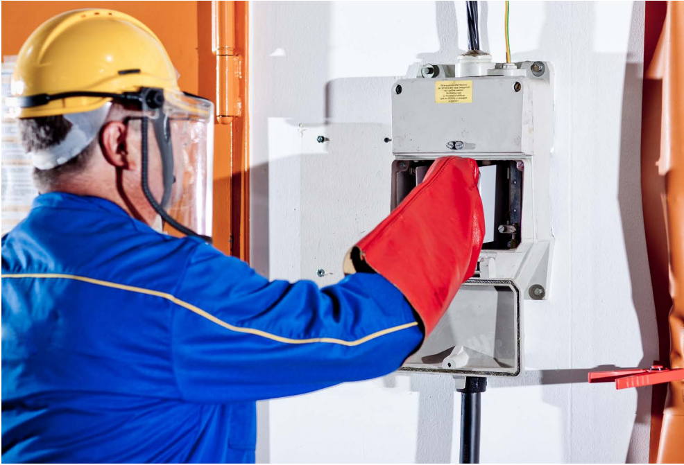
Abb. A 6-1 Arbeiten am Hausanschlusskasten: k_T = 1,0
