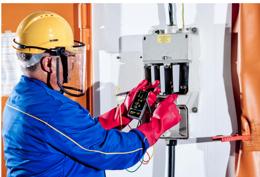
Abb. A 5-8 Arbeiten am Hausanschlusskasten
