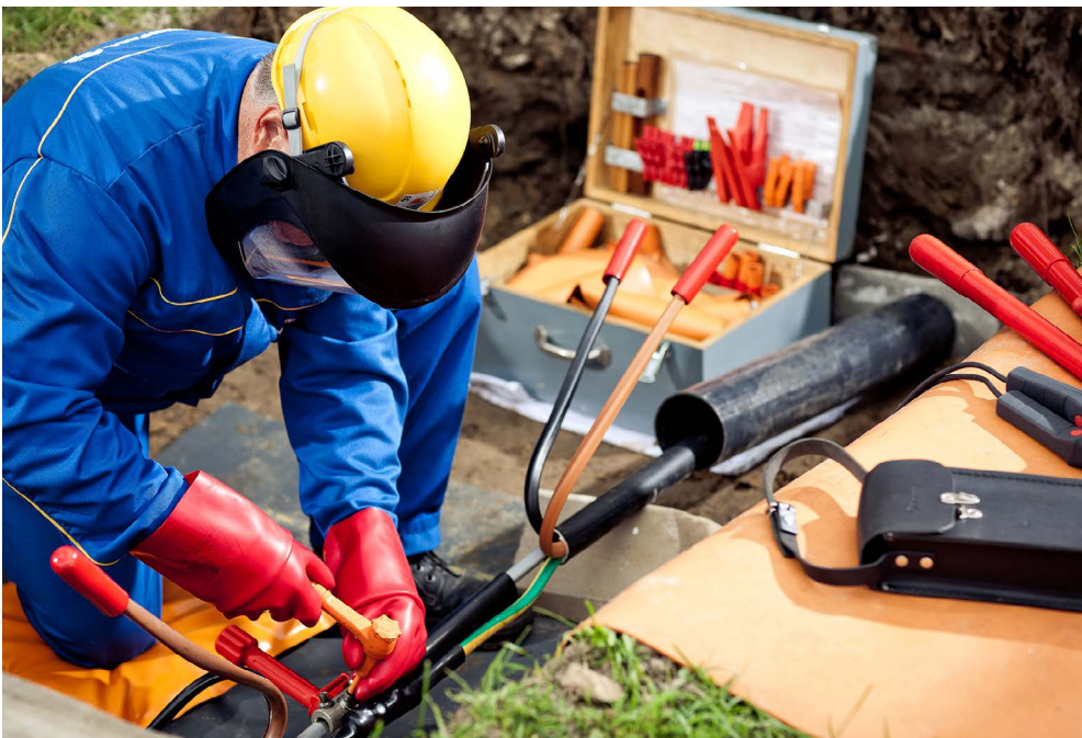
Abb. A 6-5 Muffenmontage: k_T = 1,9
