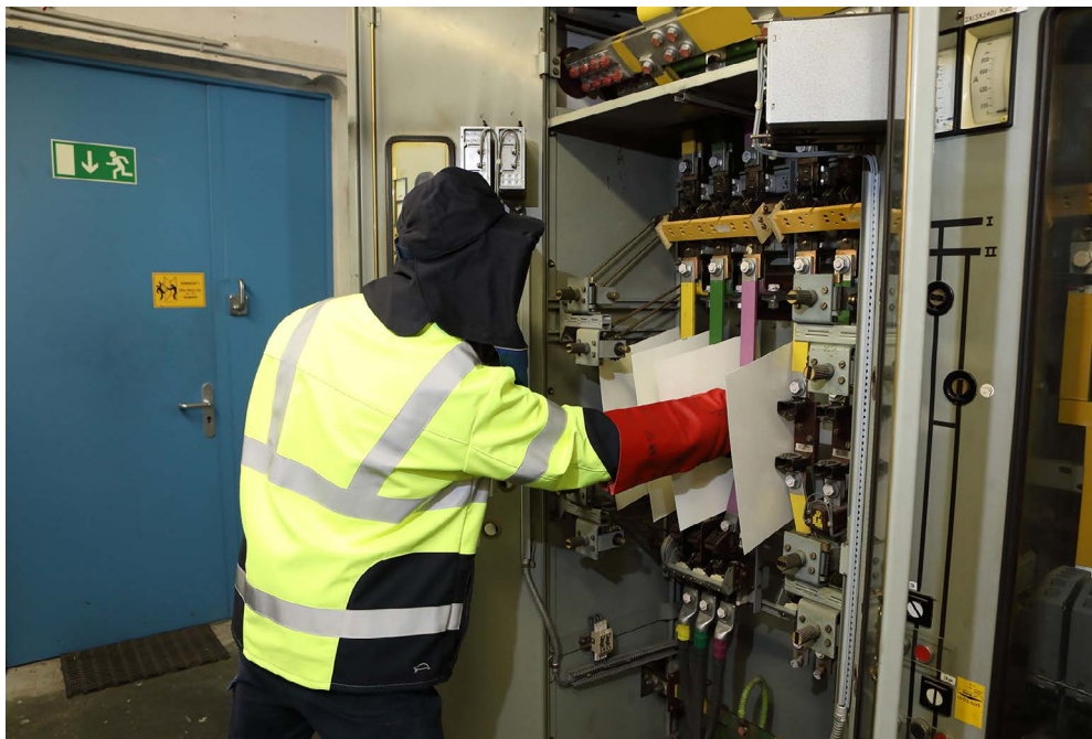
Abb. A 5-20 Entnehmen der NH-Sicherungseinsätze, zusätzlich mobile Trennstege um Potentiale gegeneinander zu isolieren
