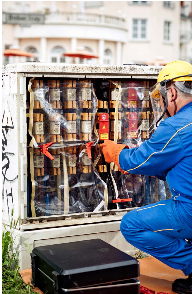
Abb. A 6-3 Arbeiten am Kabelverteilerschrank: k_T = 1,5
