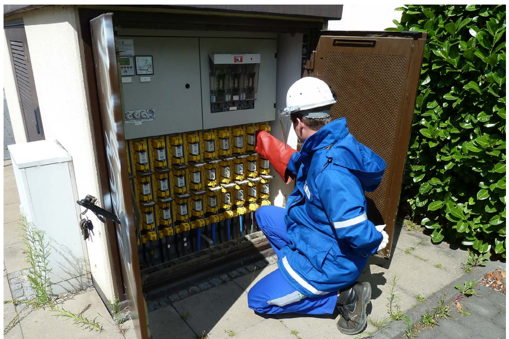
Abb. A 6-4 Arbeiten an einer Kompaktstation: k_T = 1,7
