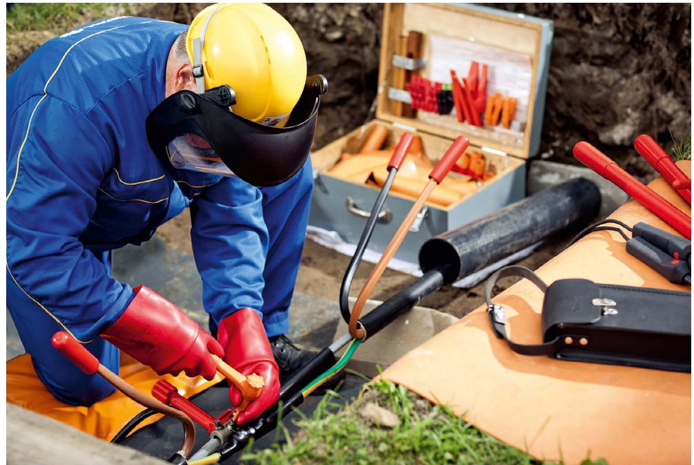
Abb. A 5-6 Arbeiten an einer Kabelmuffe
