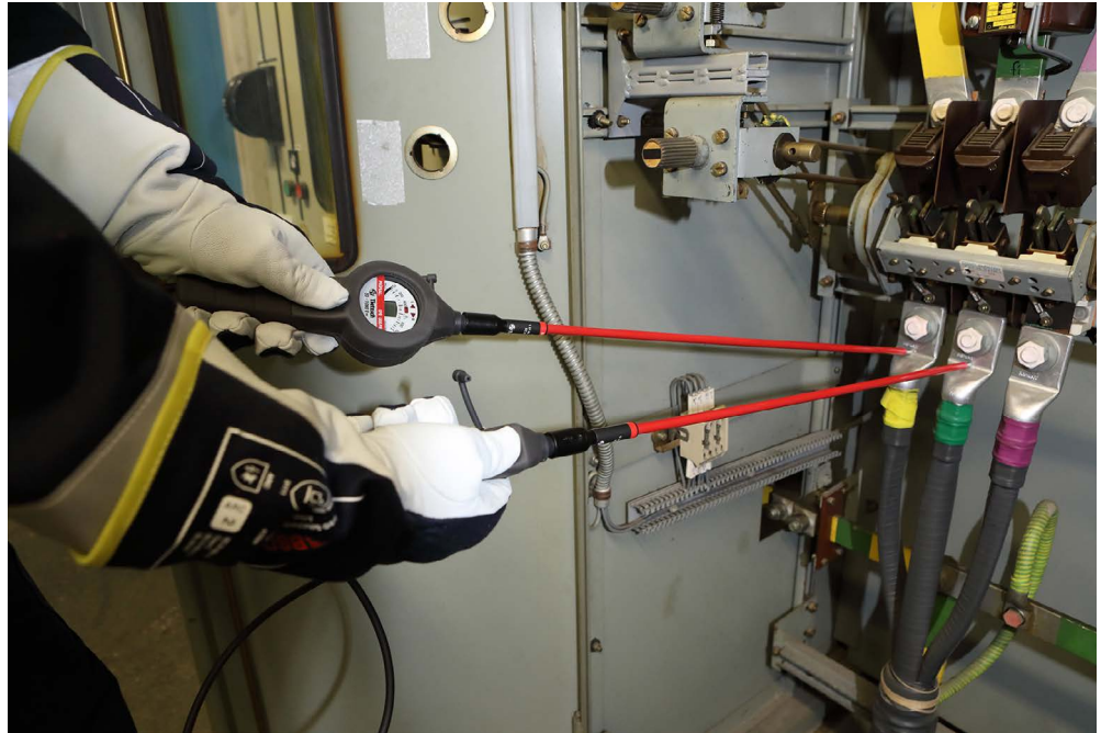
Abb. A 5-22 Feststellen der Spannungsfreiheit
