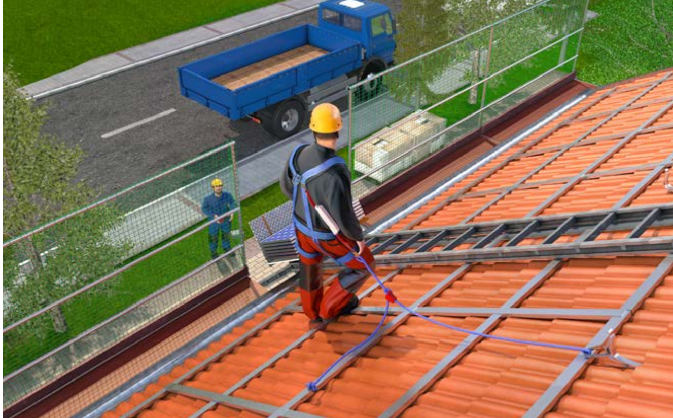
Abb. 27 Materialtransport bei entfernter Schutzeinrichtung unter Verwendung von PSAgA
