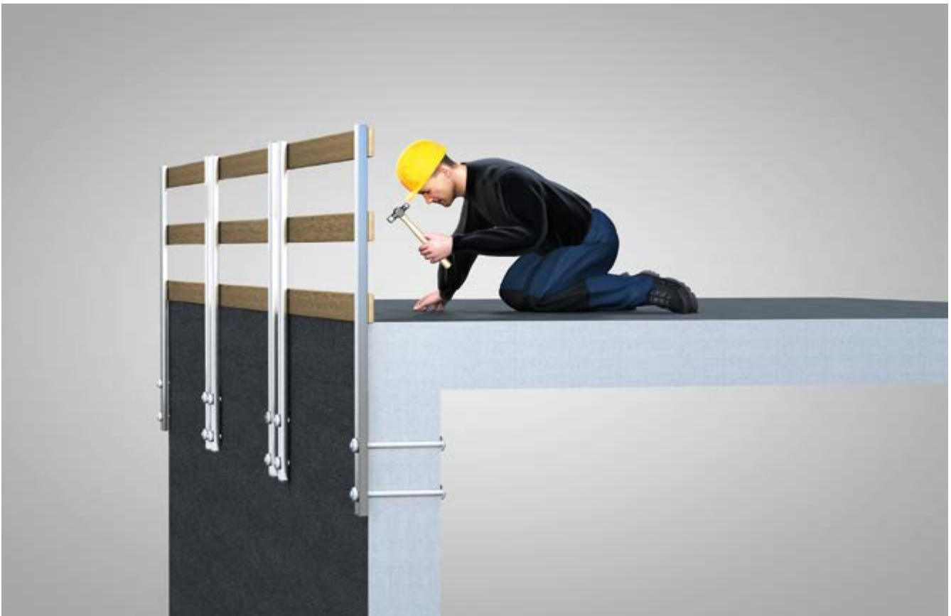
Abb. 3 Beispiel einer Absturzsisicherung, welche ab 2,00 m Höhe zwingend erforderlich ist und die direkt an der Absturzkante angebracht ist.
