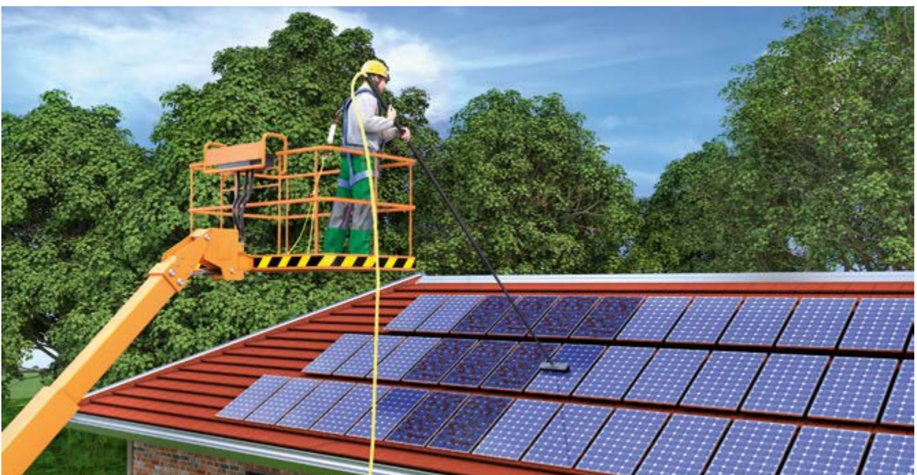
Abb. 28 Reinigung einer PV-Anlage von einer Hubarbeitsbühne aus
