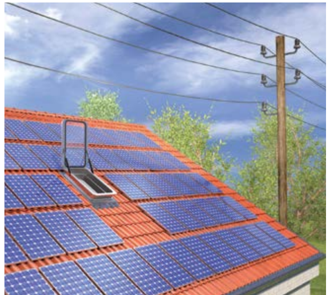
Abb. 26 Niederspannungsfreileitung in der Nähe einer PV-Anlage
