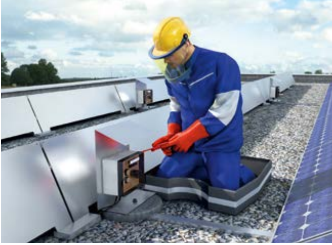
Abb. 17 Arbeiten unter Spannung mit PSA ausführen
