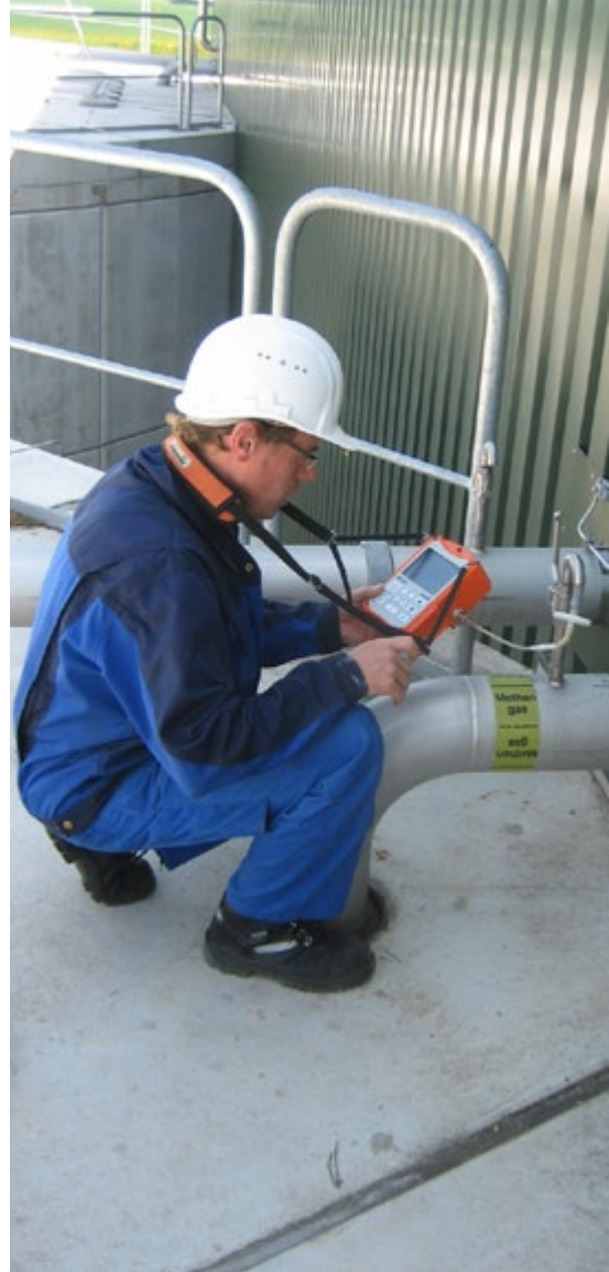
Abb. 2 Gasanalyse an einer Rohbiogasleitung
