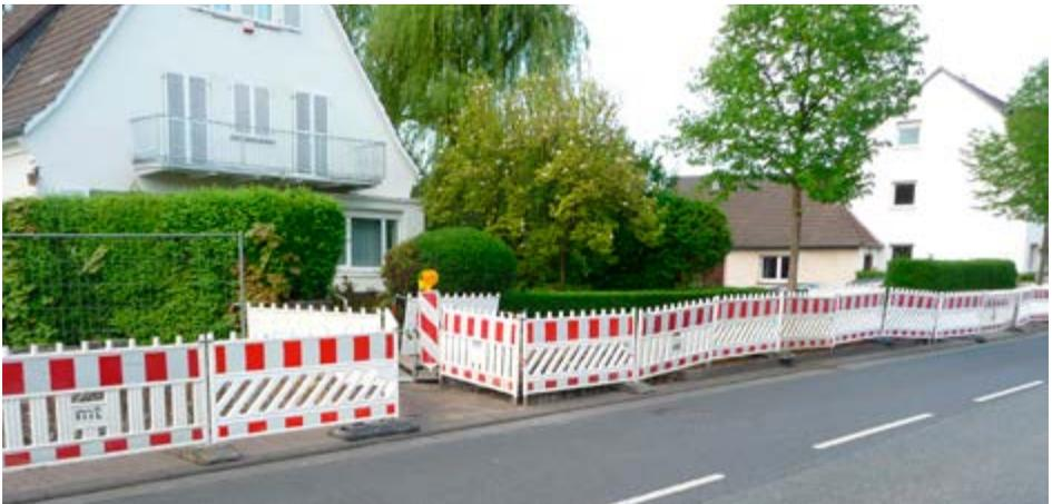
Abb. 13 Sicherung der Arbeitsstelle 2
