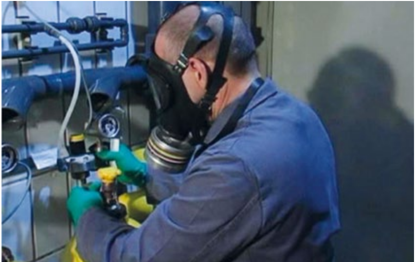
Abb. 9 Chlorgasbehälterwechsel unter Atemschutz
