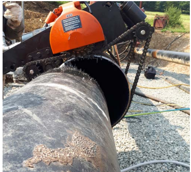
Abb. 43 Rohrfräse mit Druckluftantrieb
