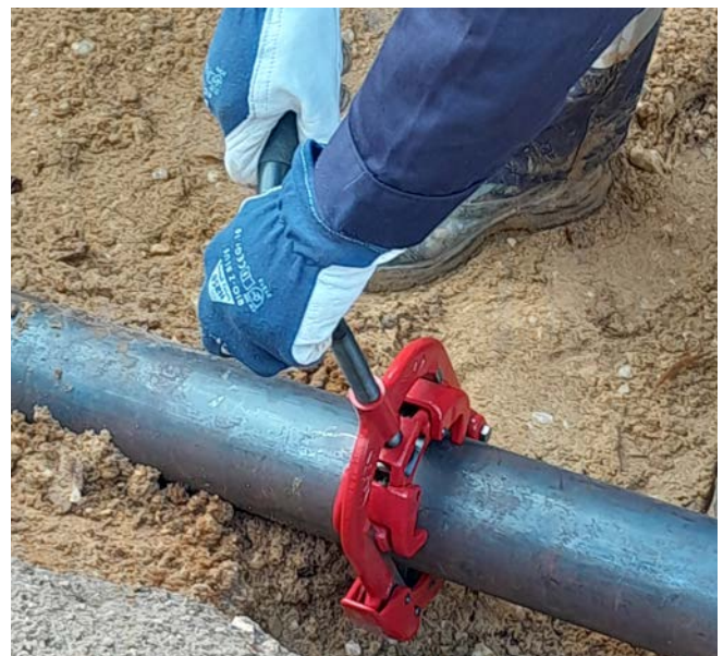
Abb. 44 Rohrschneider handbetätigt
