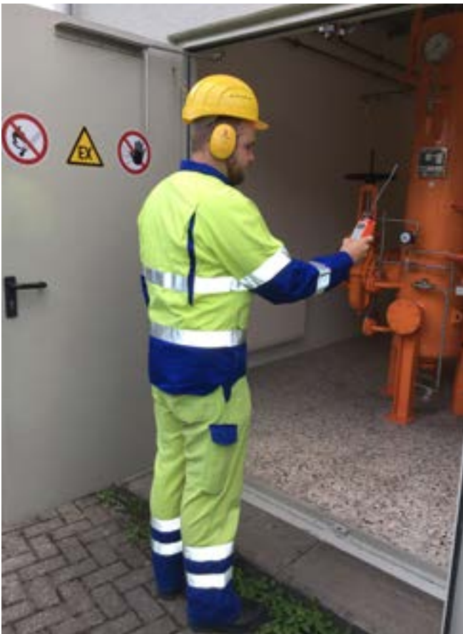
Abb. 12 Arbeitsplatzüberwachung mit einem tragbaren Gaswarngerät
