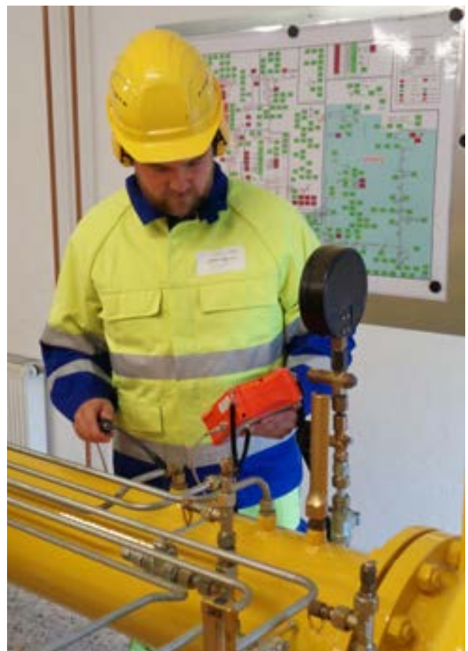
Abb. 28 Dichtheitskontrolle bei der Funktionsprüfung an einer GDRM-Anlage.
