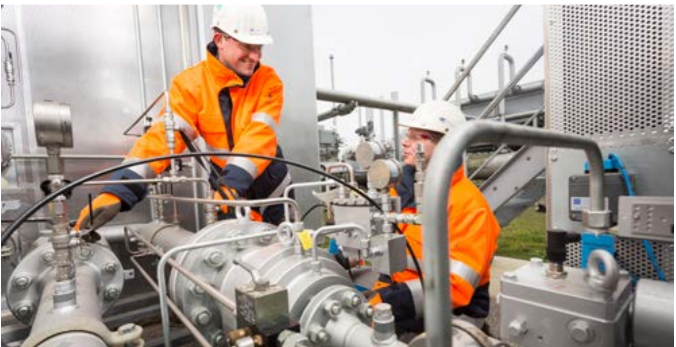
Abb. 8 Instandhaltungsarbeiten in einer GDRM-Anlage
