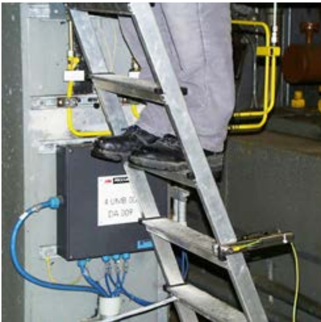
Abb. 42 Erdung einer mobilen Einrichtung (Stehleiter)
