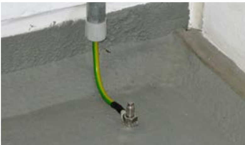
Abb. 37 Beispiel Erdungsanschluss für ableitfähigen Fußboden
