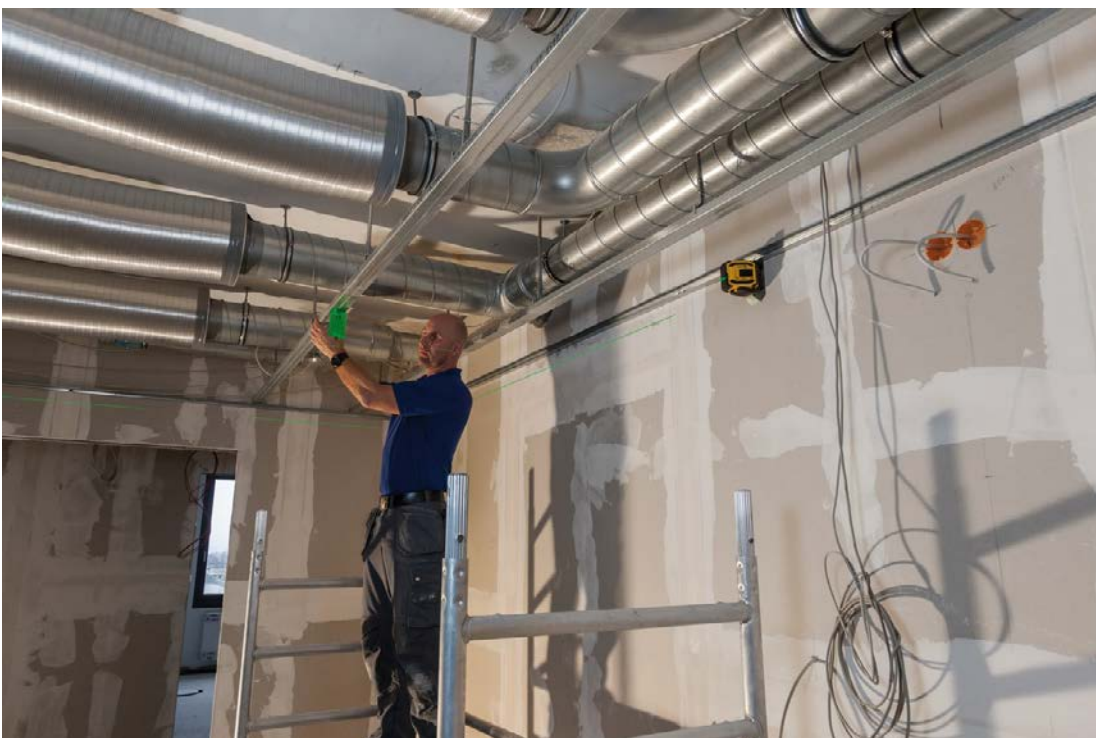
Abb. 5 Einsatz eines Linienlasers mit Zielplatte (Klasse 2, EGW für 2s eingehalten)
