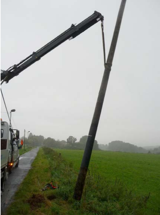
Abb. 33 Herausziehen eines Mastes mittels Kran
