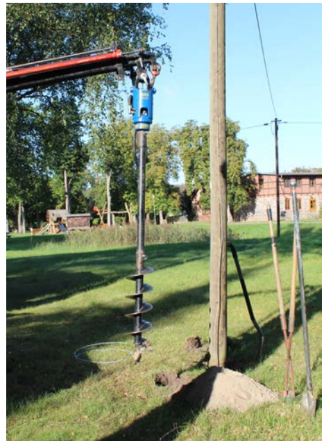
Abb. 12 Beispiel für den Einsatz eines hydraulisch betriebenen Erdbohrers
