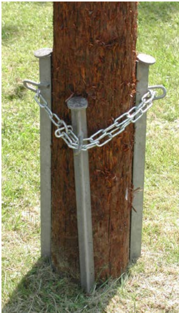
Abb. 25 Beispiel für eine Mastfußsicherung
