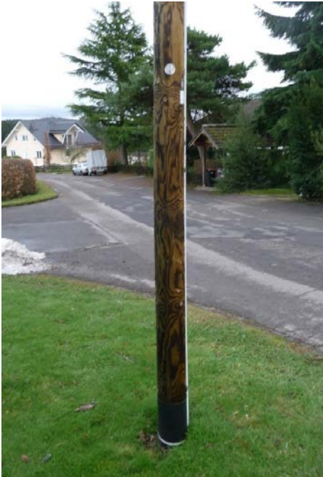
Abb. 6 Holzmaße mit beispielhafter Kennzeichnung der Einbautiefe
