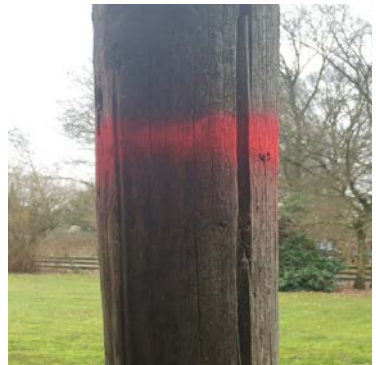
Abb. 24 Kennzeichnung eines aufgrund des Zustandes nicht ohne weitere Sicherungsmaßnahmen zu besteigenden und zum Austausch vorgesehenen Mastes
