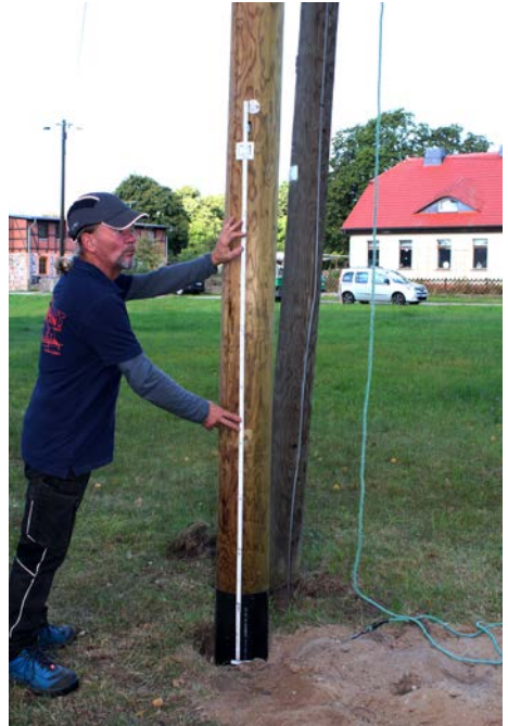
Abb. 6 Holzmaße mit beispielhafter Kennzeichnung der Einbautiefe
