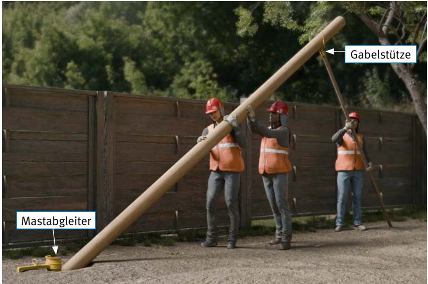
Abb. 13 Beispiel für ein manuelles Stellen eines TK-Holzastes unter Verwendung eines Mastableiters und einer Gabelstütze
