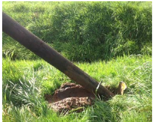
Abb. 14 Mastableiter zum Stellen von Holzmasten in Mastlöchern
