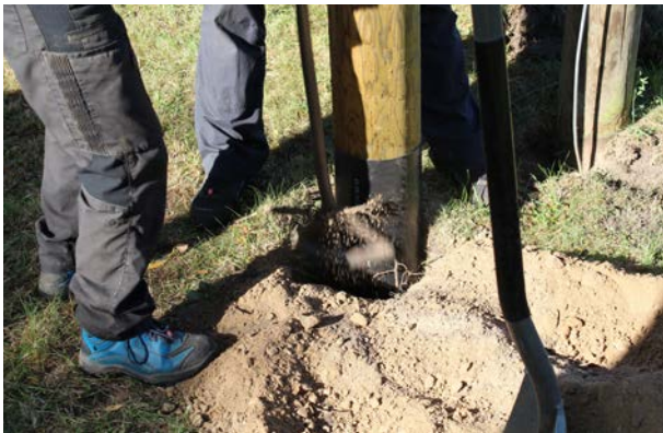
Abb. 15 Verdichten des Mastloch mittels Handstamper
