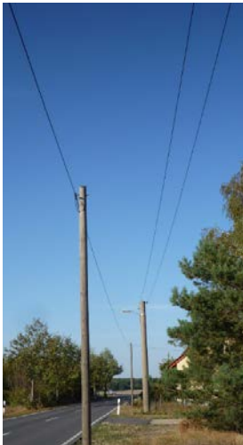
Abb. 31 Näherung TK-Linie mit Freileitung der EVU
