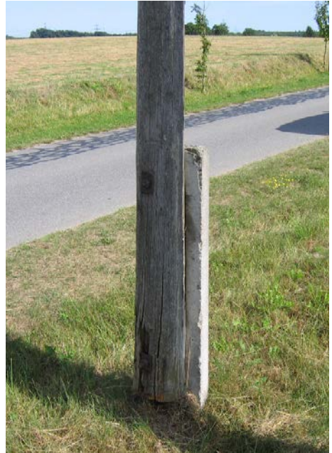
Abb. 37 Betonmastfußtyp IV als Einzelbetonmastfuß
