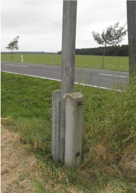
Abb. 36 Betonmastfußtyp IV als Doppelbetonmastfuß
