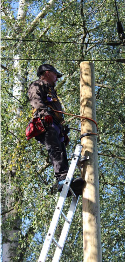
Abb. 29 Gesichertes Arbeiten auf Anlegeleitern an Holzmasten
