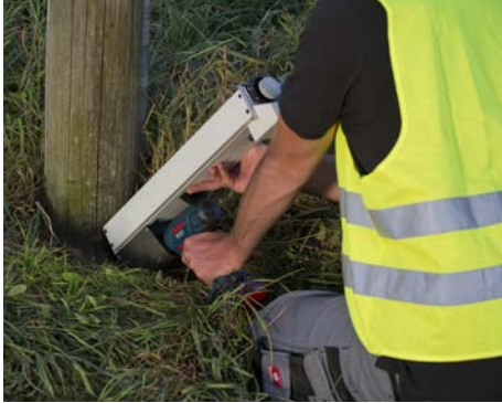
Abb. 19 Schrägbohrung unterhalb der Erdgleiche
