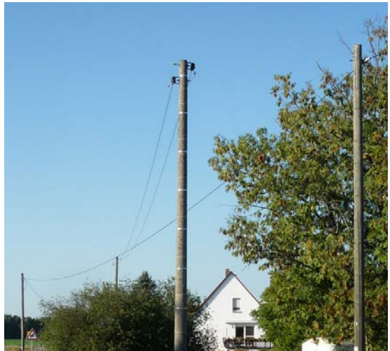
Abb. 32 Kreuzung TK-Linie mit Freileitung der EVU
