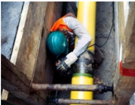
Bild A6.7: Rohrgraben mit Holzverbau:
