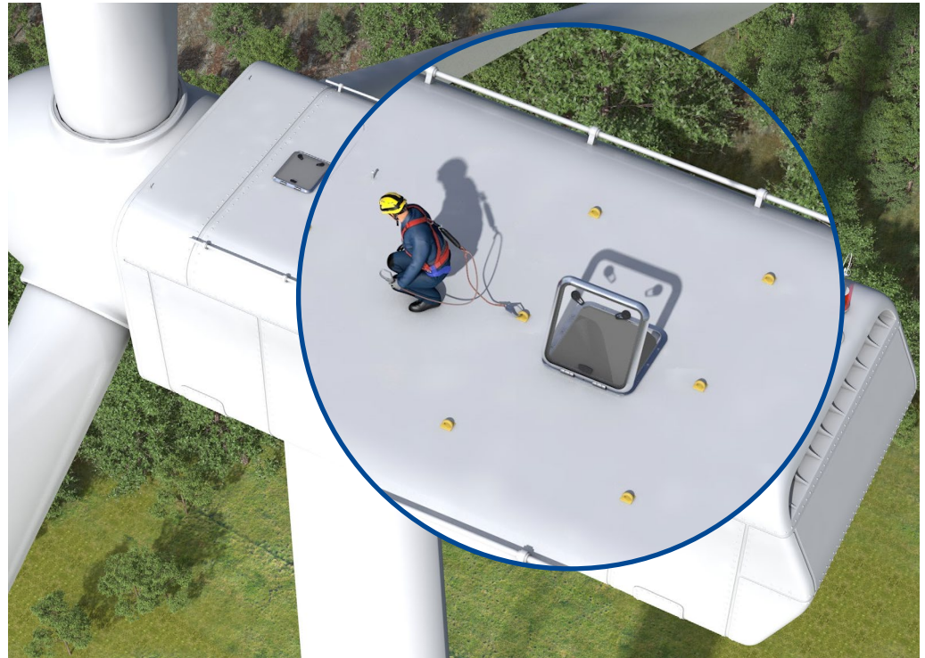
Abb. A11-1 Monteure auf Maschinenhausdach
