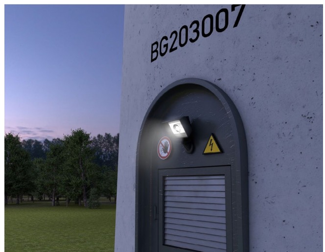
Abb. B4-1 Zugang mit ausreichender Außenbeleuchtung
