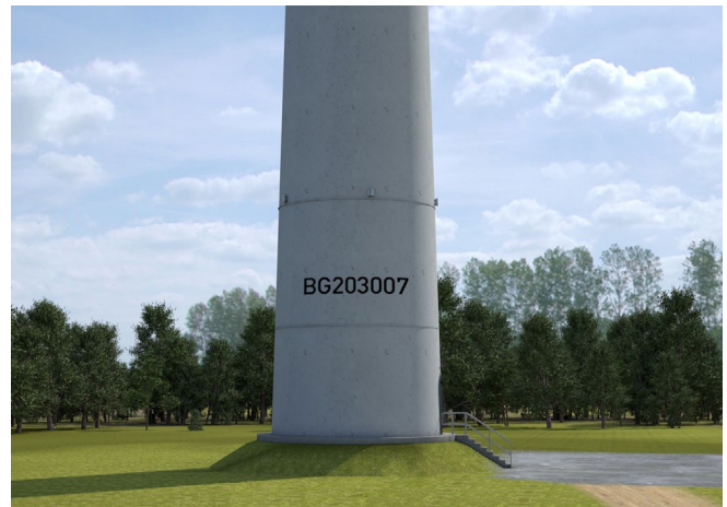
Abb. A13-6 Kennzeichnung WEA (Anlagennummer) wegseitig
