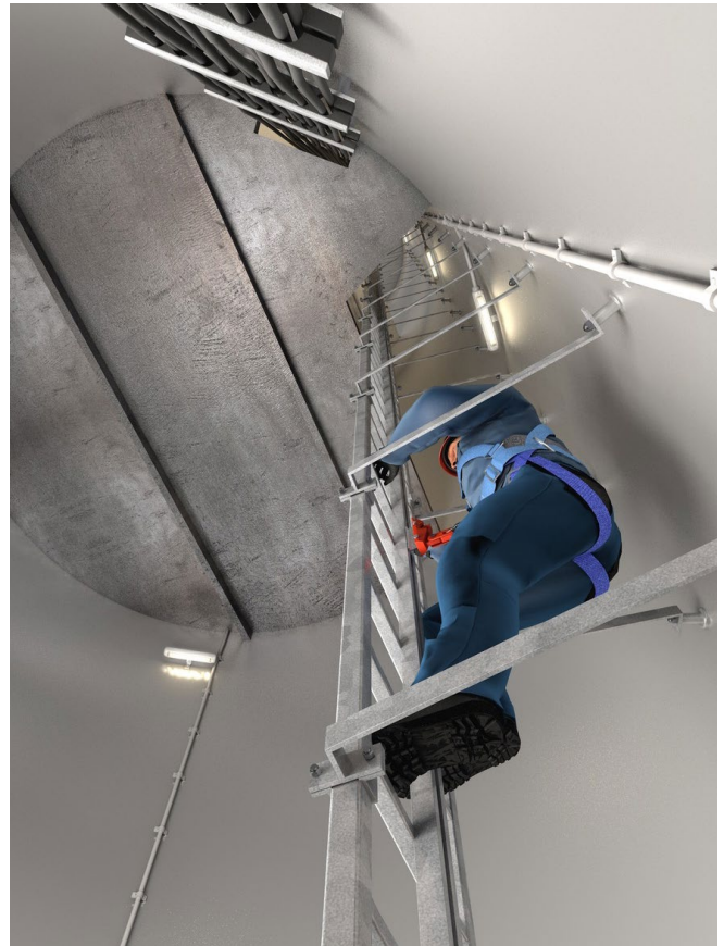
Abb. B2-1 Steigleiter mit Steigschutzeinrichtung
