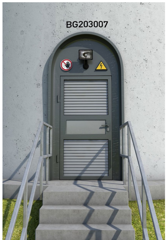
Abb. A13-7 Kennzeichnung WEA (Anlagennummer)
