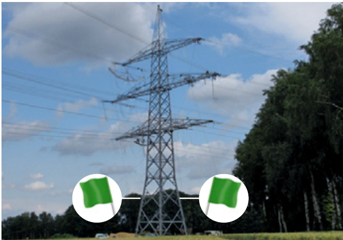
Bild 18: Zeigt einen zum Arbeiten freigegebenen Hochspannungsmast bei dem alle Systeme freigeschaltet sind. Die Kennzeichnung mittels grüner Flaggen erfolgt im Bereich des Masteintritts an den Steiggängen.
