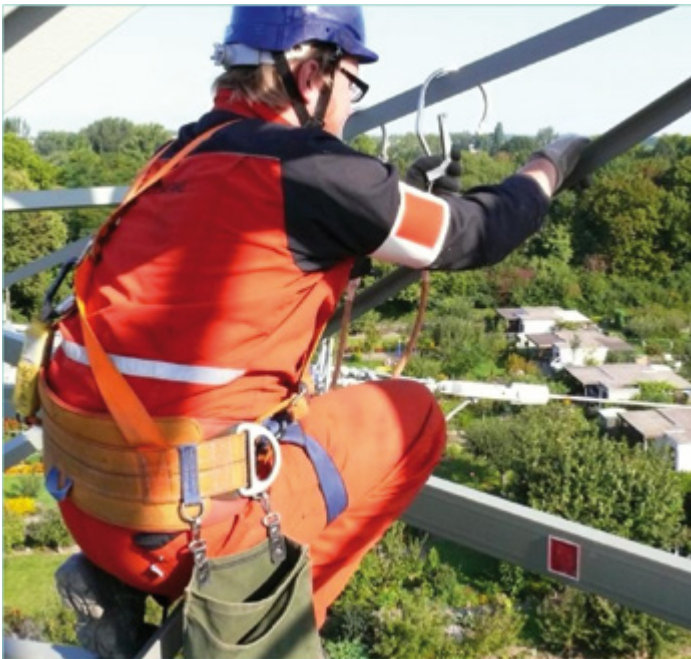
Bild 16: Durch den Einsatz von Armbinden in Kombination mit einer eindeutigen Stromkreiszeichnung mit Hilfe von geometrischen Formen (Schild am Masteinstieg, Traversenkennzeichnung) ist dieser Arbeitsbereich gekennzeichnet.
