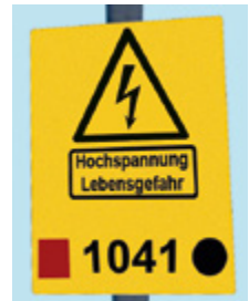
Bild 16: Durch den Einsatz von Armbinden in Kombination mit einer eindeutigen Stromkreiszeichnung mit Hilfe von geometrischen Formen (Schild am Masteinstieg, Traversenkennzeichnung) ist dieser Arbeitsbereich gekennzeichnet.
