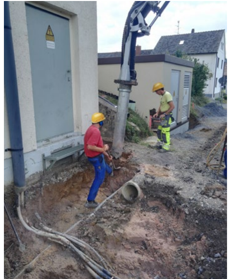
Abb. 4 Saugrohr eines Saugbaggers im Einsatz
