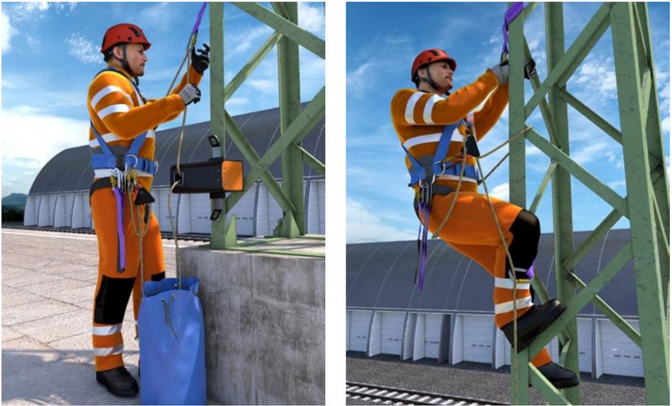
Abb. 5.3.2 1 Besteigung eines Mastes unter Anwendung der Schlaufenmethode
