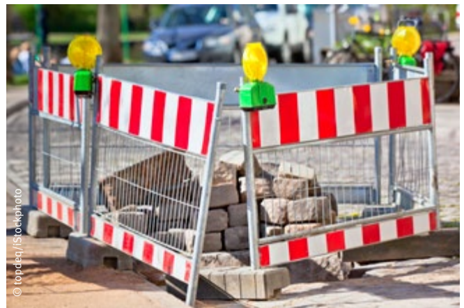
Abb.3 Baustelle mit Baken und Lichtzeichen gesichert
