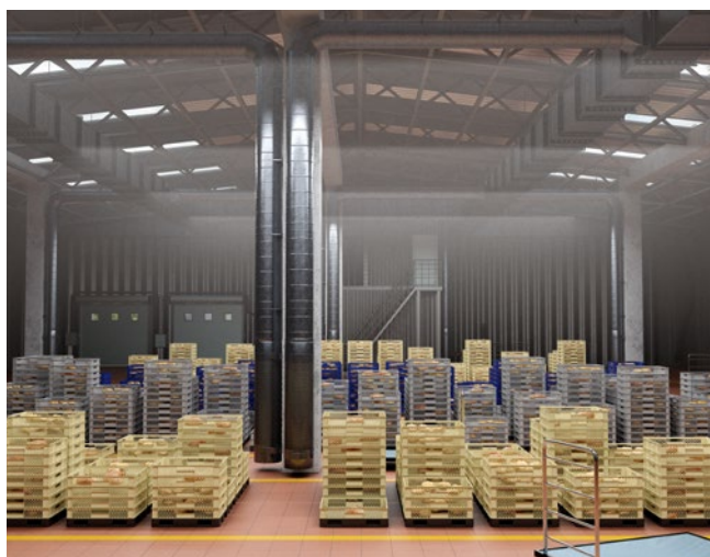
Abb. 2 Darstellung eines Backwarenverteilzentrums Gestapelte heiß-warme Backwaren geben Wärme und Feuchte an die Raumluft ab
