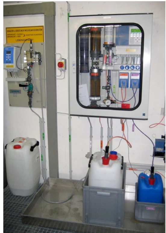
Abb. 6 Chlordioxid nach dem Salzsäure-Natriumchloritverfahren
