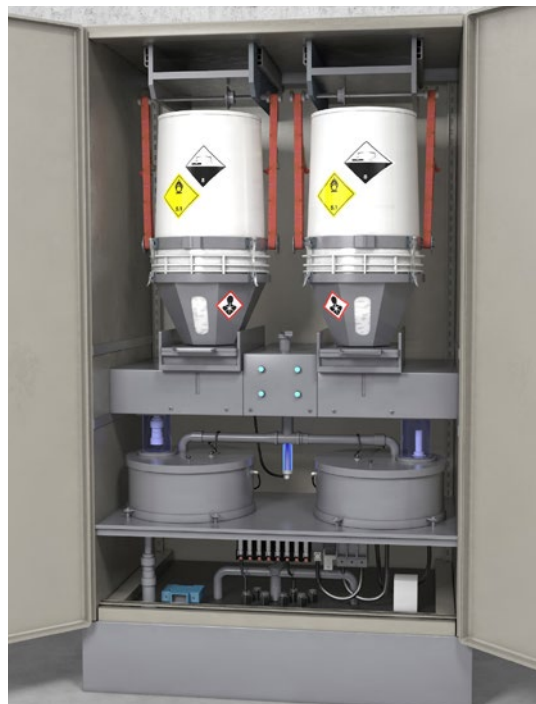
Abb. 5 Calciumhypochloritverfahren
