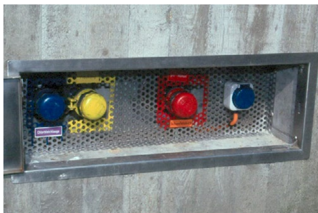
Abb. 4 Verwechslungssichere Einfüllstutzen
