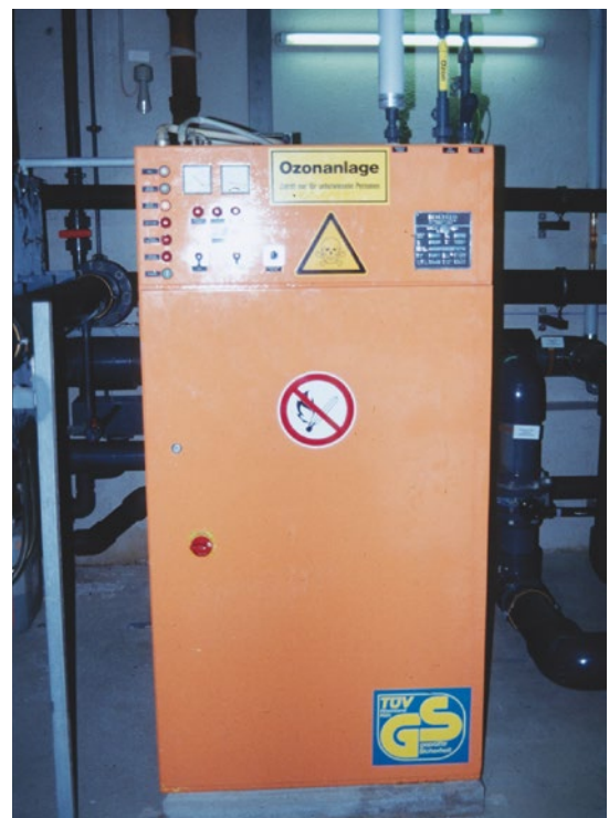
Abb. 9 Ozonerzeugungsanlage
