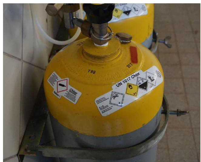
Abb. 2 Kennzeichnung von Chlorgasflaschen
