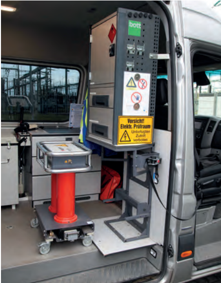
Messwandler auf Rollen.
