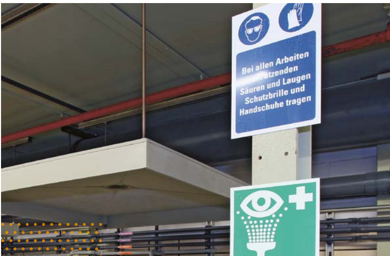
Gefahrstellen und Rettungseinrichtungen müssen gekennzeichnet werden.
