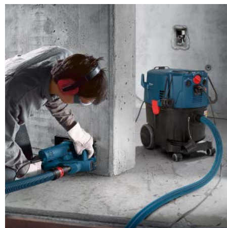
Schlitze fräsen: 102 dB (A)
