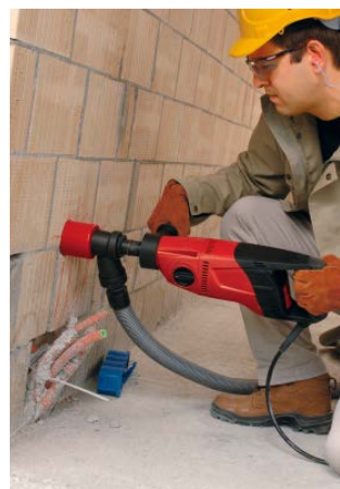
Unterputzdosen bohren: 100 dB (A)
