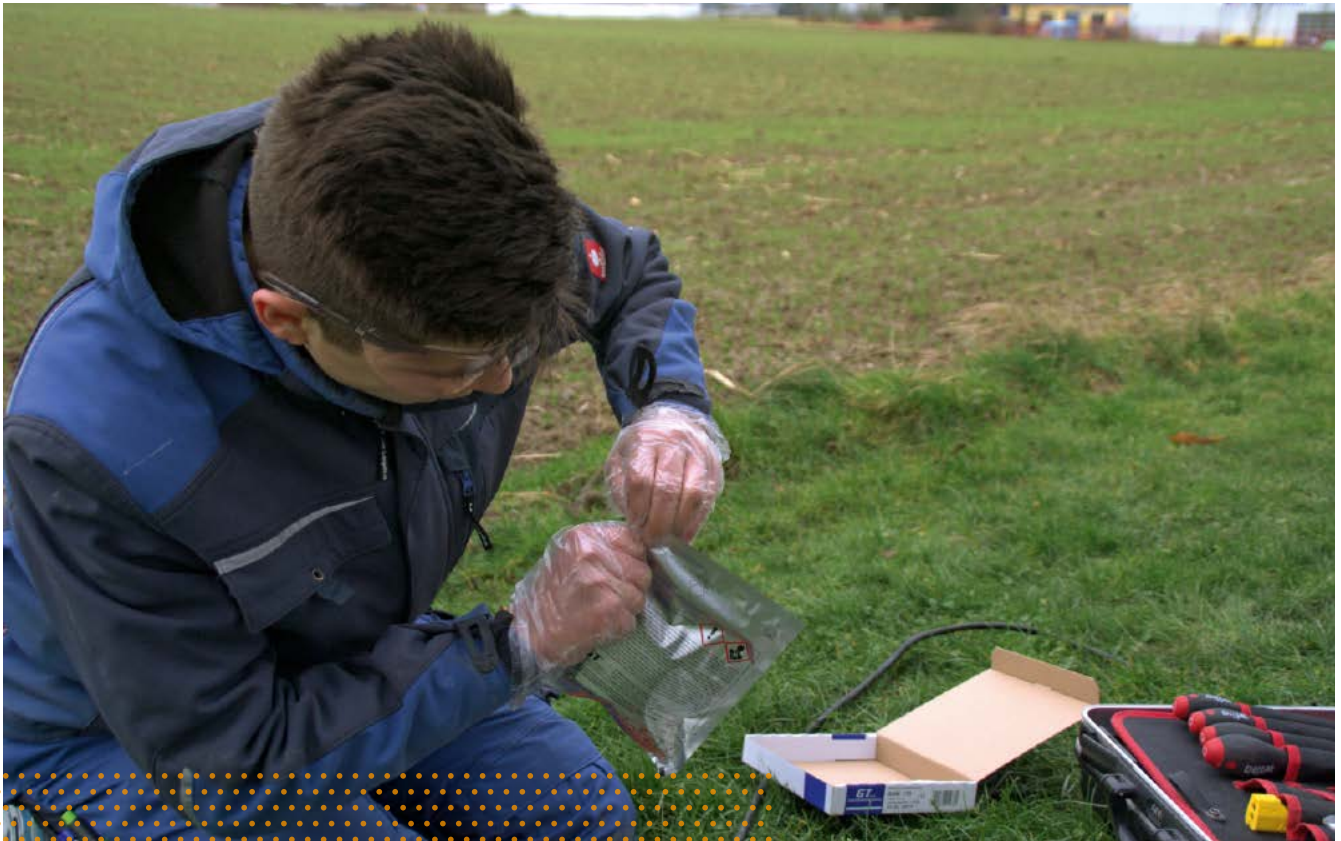
Im Doppelkammerbeutel können Harz und Härter ohne Hautkontakt vermischt werden.
