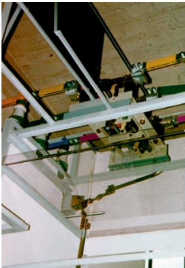
Bild 3.4.1 Polycarbonatplatte unter einem Sammelschienenlängstrennschalter
