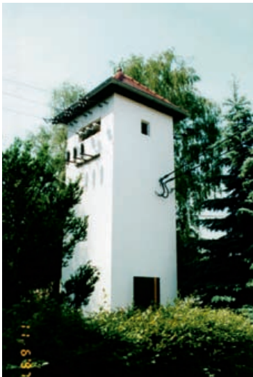
Bild 3.3.1 Freileitungsturmstation
