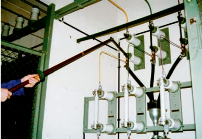
Bild 3.1.3 Einpolig zu betätigender Trennschalter
