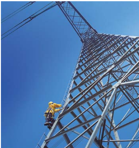
Abb. 5 Beispiel für einen Steigbolzengang mit gespanntem Stahlseil als Steigschutzeinrichtung. Das Stahlseil gilt als feste Führung
