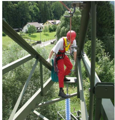
Abb. 11 Beispiel für den Einsatz von Steigbolzen mit Sicherheitseinrichtung in einer Traverse.
