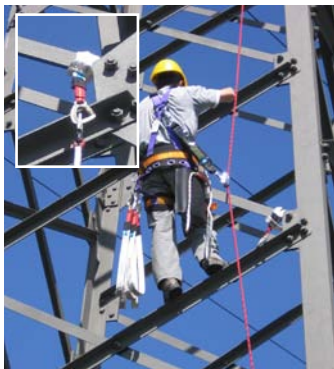
Abb. 44 Nach Befestigung des Sicherungsseils an einem Anschlagpunkt können weitere Versicherte mittels mitlaufendem Auffanggerät den Mast besteigen.
