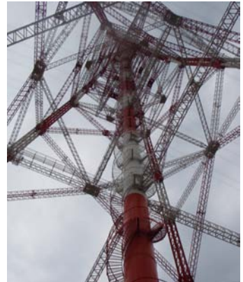
Abb. 1 Freileitungsmast mit Aufzugschacht, Bühnen und Treppen an der Elb- kreuzung
