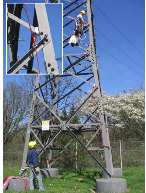
Abb. 43 Der erste aufsteigende Versicherte installiert mit Bandschlaufen und Karabinerhaken Anschlagpunkte und hängt das Sicherungsseil in diese ein. Während des gesamten Aufstiegs ist er an einer Auffangöse seines Auffanggurtes am Sicherungsseil gesichert. Der Versicherte am Boden führt die erforderliche Seillänge nach. Im Absturzfall blockiert die Seilbremse das nachlaufende Sicherungsseil. Ein Retten ist durch weiteres Nachlassen des Sicherungsseils unmittelbar möglich.
