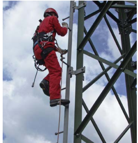
Abb. 46 Beispiel für einen Steigbolzengang. Um die Absturzhöhe möglichst gering zu halten, ist hier jeder vierte Steigbolzen mit einer Sicherheitseinrichtung ausgeführt.
