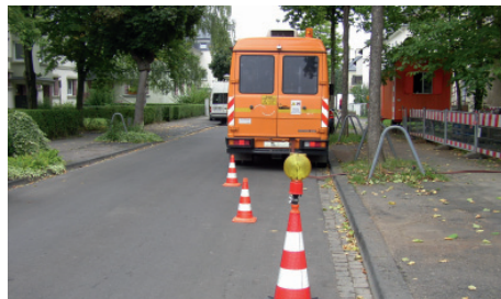
3.3.1 Bild 2 Verwendung eines Blitz-Leitkegels an der 1. Leitkegel-Position
