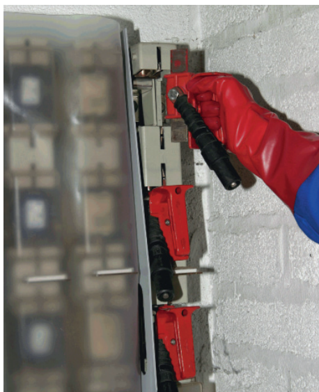
3.3.3 Bild 3 Sicheres Einsetzen der Anschlussadapter für die Messleitungen unter Verwendung von isolierenden Schutzhandschuhen
