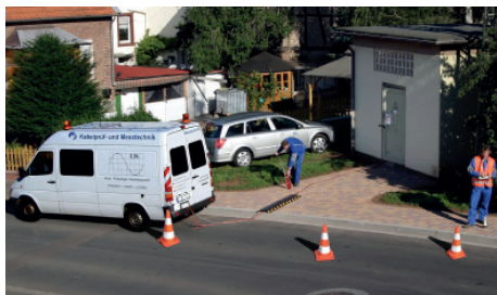
3.3.1 Bild 1 Aufstellung im fließenden Verkehr, Warnweste, Fahrzeugkennzeichnung nach DIN 30 710
