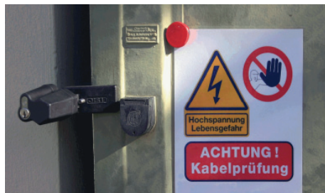
3.3.2 Bild 2 Sicherung einer Stationstür mit Spezial- schloss, Warnschild
