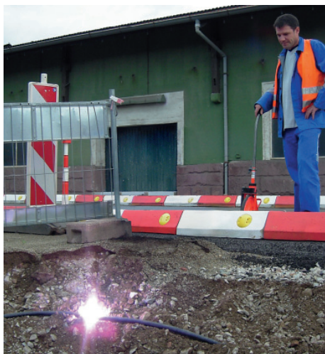
3.3.4 Bild 1 Gefährdung durch Überschlag während der Messung an einer frei- liegenden Kabeltrasse
