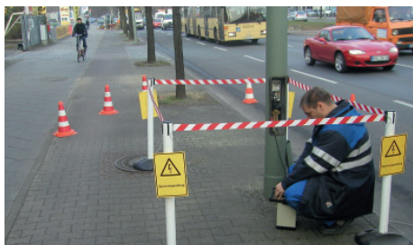
3.3.1 Bild 3 Prüfaufbau mit tragbarem Prüfgerät, Beispiel am Beleuchtungsmast, Abgrenzung durch Ausziehband
