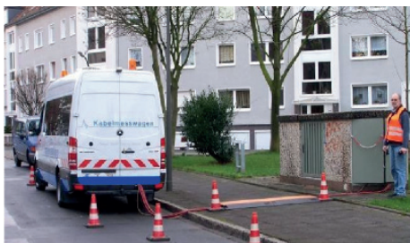
3.3.2 Bild 1 Kabelverlegung quer über einen Gehweg, Kennzeichnung mit Leitkegeln
