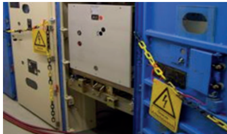
3.3.3 Bild 2 Kennzeichnung des Arbeitsbereiches
