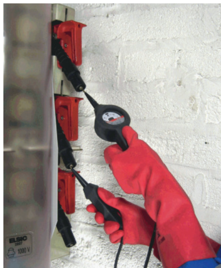
3.3.3 Bild 4 Spannungsfreiheit feststellen
