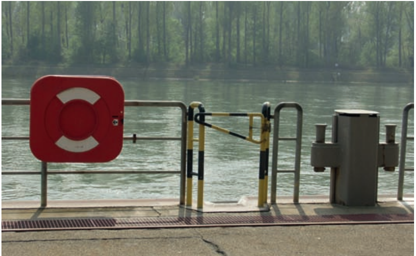
Abb. 12.2.1.1 Behälter für ein geschütztes Aufbewahren von Rettungsringen und -leinen
