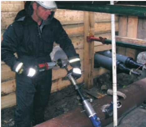
Abb. 7.1 Beispiel für den Einsatz eines Anbohrverfahrens
