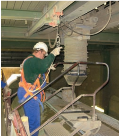
Abb. 12.1.3.1 Beispiel einer Zugangsbühne zum Besteigen von Silo-waggons. Ein Schienensystem verläuft an der Hallendecke in Zugfahrtrichtung.
