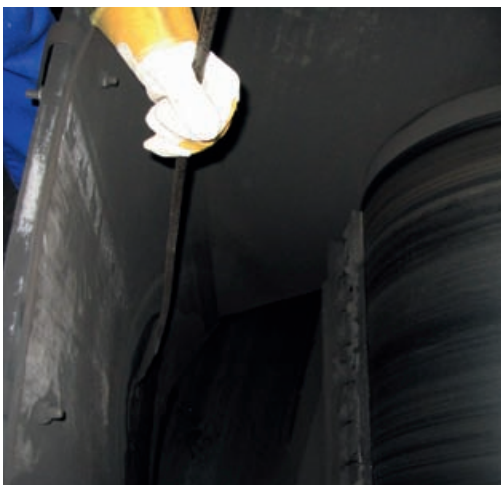
Abb. 4.4.1.3 Stocharbeiten unter Einsatz eines Pneumatikhammers am Aschetrichter oberhalb des Nassentaschers eines mit Braunkohle befeuerten Dampferzeugers
