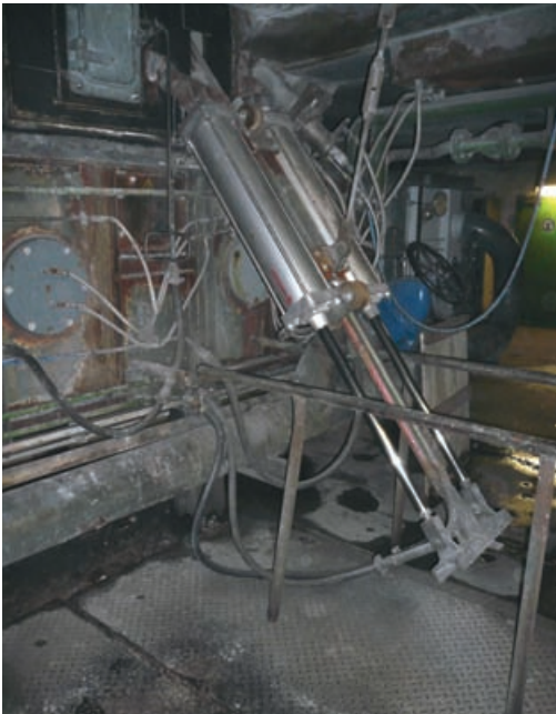
Abb. 4.4.1.1 Beispiel für eine pneumatisch betriebene Stochereinrichtung. Gute Erfahrungen wurden hiermit an kleineren Dampferzeugern mit Schmelzkammerfeuerung gesammelt.
