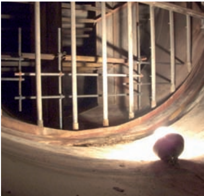
Abb. 8.5.1.1 Beispiel für eine Abgrenzung eines Arbeitsbereiches in einem Rauchgaskanal durch Gerüststangen
