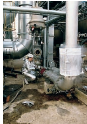
Abb. 7.2 Beispiel für den Einsatz eines Frostverfahrens
