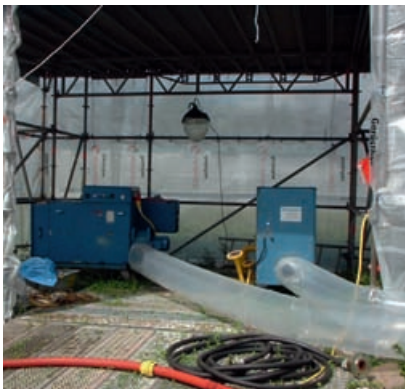
Abb. 8.4.1 Beispiel für ein Belüftungsgebläse mit Luftzuführung zu einem erdgedeckten Tank
