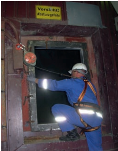
Abb. 8 Bei Erstbefahrungen von Anlagenteilen mit Absturzgefahr ist PSA gegen Absturz einzusetzen.
