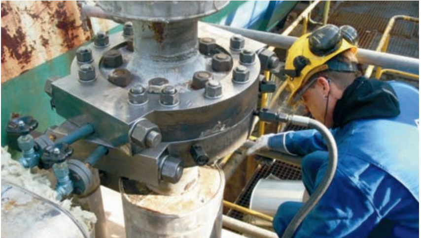
Abb. 7.3 Beispiel für den Einsatz eines Compound-Abdichtverfahrens zur Abdichtung einer Leckage an einer Flanschverbindung
