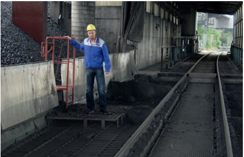
Abb. 12.1.1.3 Beispiel für eine feste Bedienplattform an einem Kohlebunker, die ein Betreten der Bunkerroste weitgehend entbehrlieh macht.
