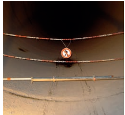
Abb. 8.5.1.2 Auch Ketten sind als Abgrenzung für Zugangswege und Arbeitsbereiche geeignet, sofern keine Absturzgefahren vorliegen.
