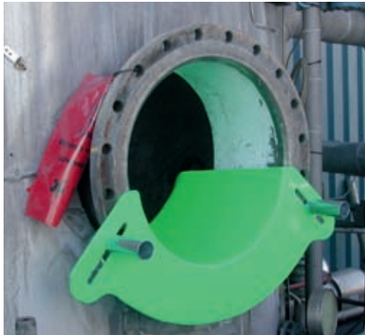
Abb. 15.1.1 Beispiel für den Einsatz einer Rettungsrutsche zum Retten einer Person durch eine seitlich eingebaute Einsteigöffnung eines Anlageteils [siehe auch Information „Retten aus Behältern, Silos und engen Räumen“ (BGI 5028)]
