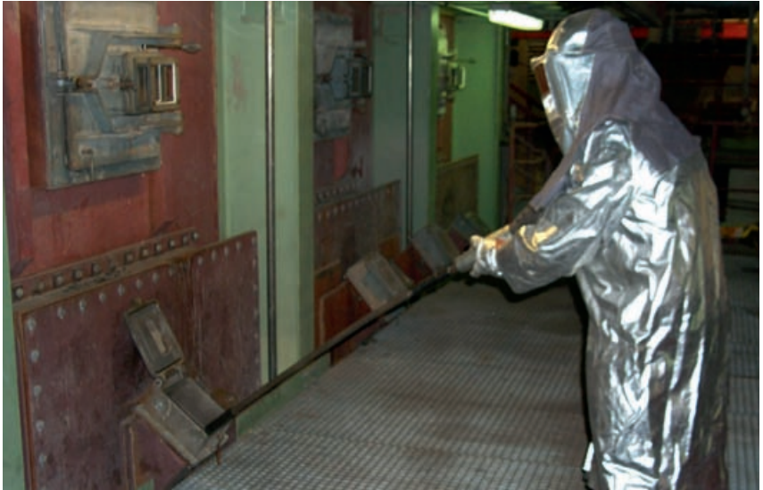
Abb. 4.4.1.3 Stocharbeiten unter Einsatz eines Pneumatikhammers am Aschetrichter oberhalb des Nassentaschers eines mit Braunkohle befeuerten Dampferzeugers
