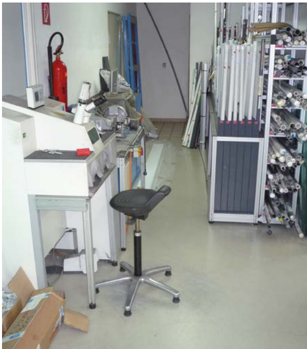
Hier wurde in unzulässigerweise ein provisorischer Arbeitsplatz im Verkehrsweg errichtet. Außerdem sind durch das auf dem Boden abgestellte Material Stolperstellen entstanden.
