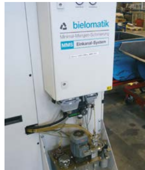
Diese kleine Einheit ist das Versorgungssystem der Minimalmengenschmierung an einem Bearbeitungszentrum.
