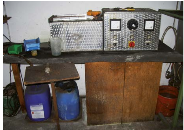
An dieser Galvanik muss noch die Gefährdungsbeurteilung durchgeführt werden!
