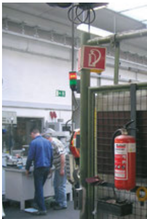
So hängen die Feuerlöscher richtig. Die Standorte sind leicht zugänglich und mit den entsprechenden Hinweisschildern gekennzeichnet.
