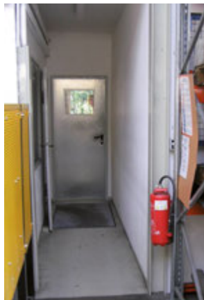
So hängen die Feuerlöscher richtig. Die Standorte sind leicht zugänglich und mit den entsprechenden Hinweisschildern gekennzeichnet.
