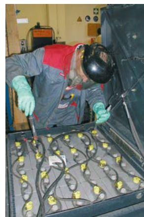
Beim Nachfüllen von Schwefelsäure in die Batterie muss der Mitarbeiter persönliche Schutzausrüstung benutzen.
