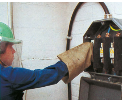
Schutzmaßnahmen beim Einsetzen und Herausnehmen von NH-Sicherungseinsätzen
