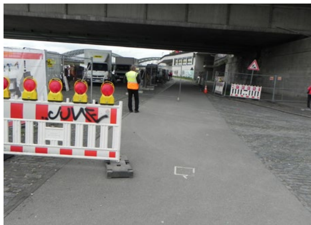
Absperrungen im Straßenverkehr
