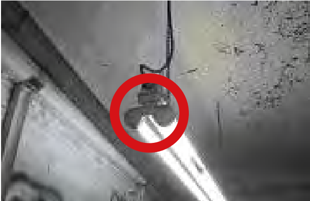
Auch im Lacklager auf den EX-Schutz achten! Lösungsmitteldämpfe bilden eine explosive Atmosphäre.
